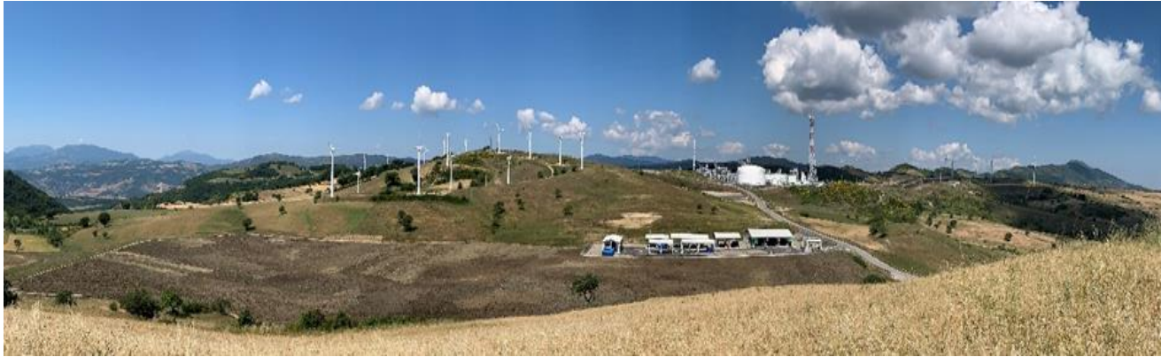
Foto 26 – Area Dumping D5
