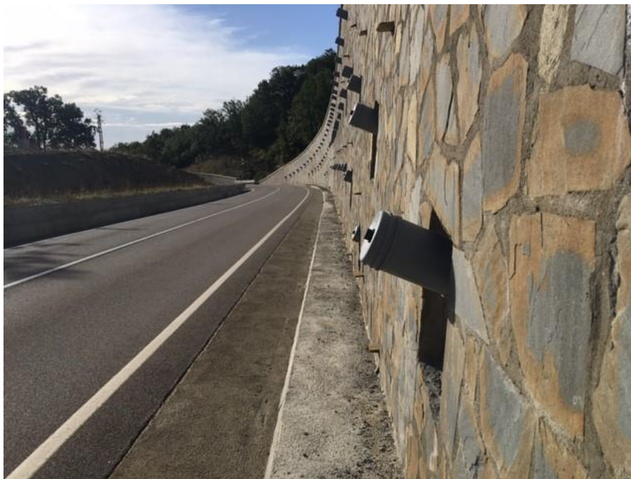
Foto 21 - Vista laterale paratia con testa tiranti
