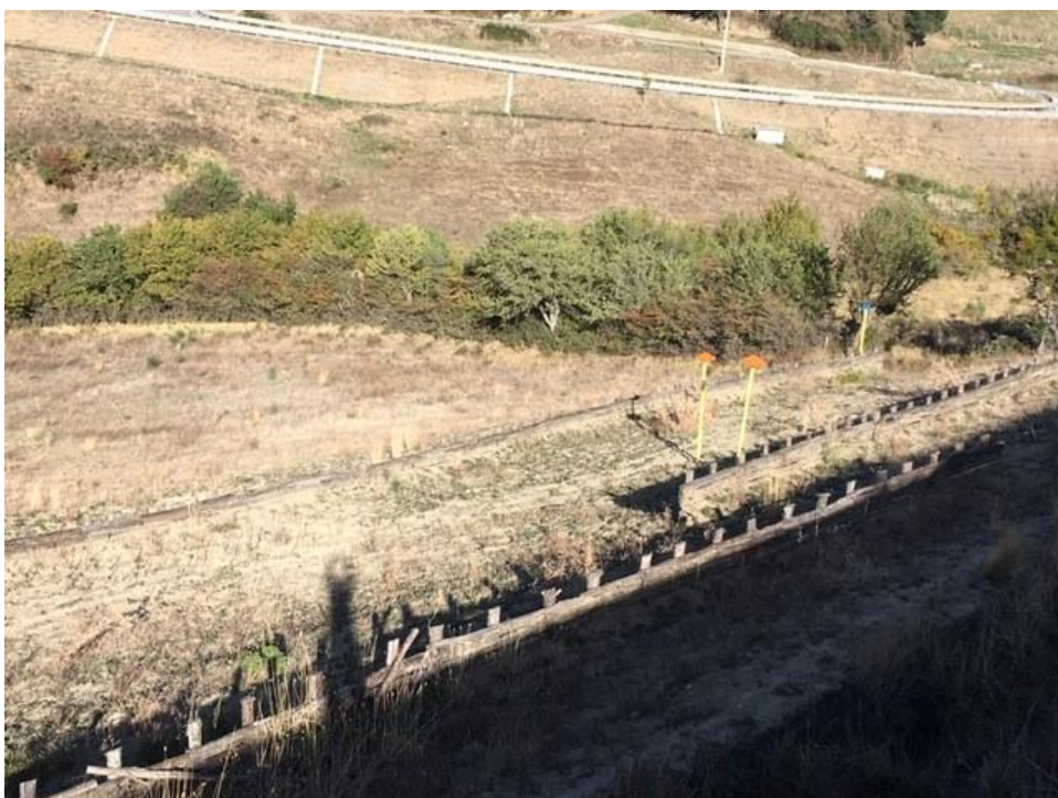
Foto 33 – Flowline, particolare Fascinate a valle della Strada di Accesso
