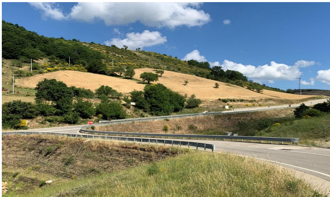
Foto 14 - Rinverdimento terre rinforzate (lungo strada di accesso)
