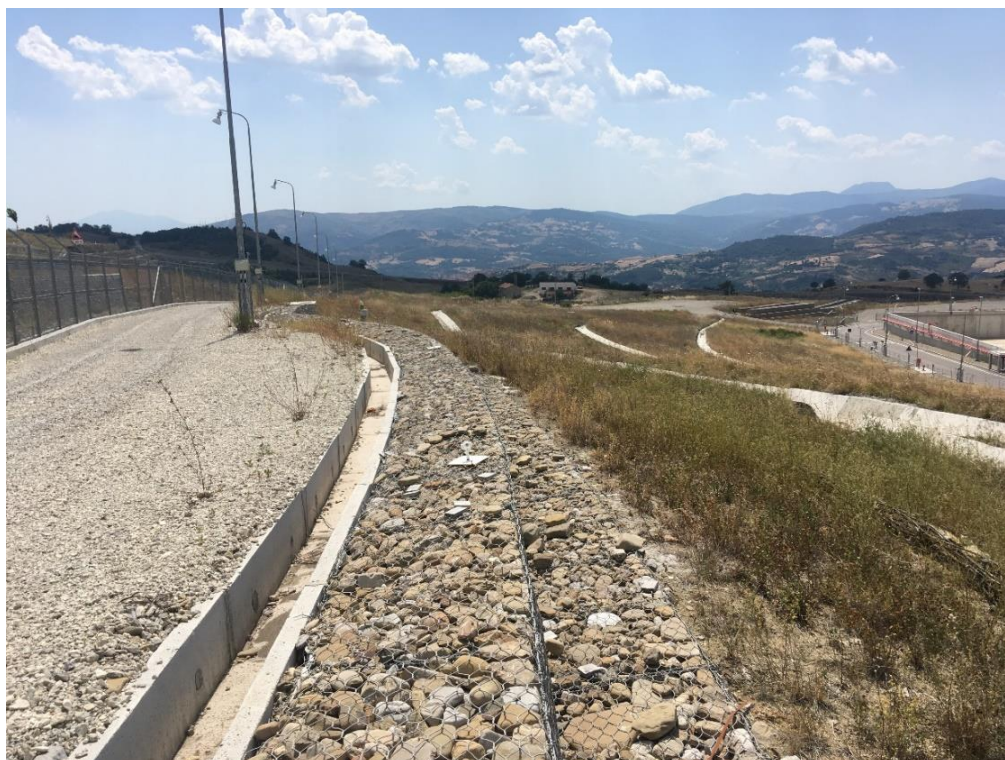
Foto 35 – Gabbionata di contenimento Patrol road
