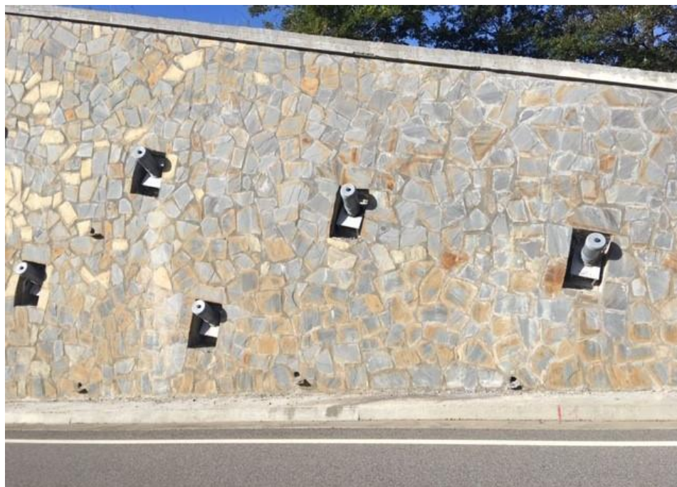
Foto 20 - Prospetto paratia con testa tiranti
