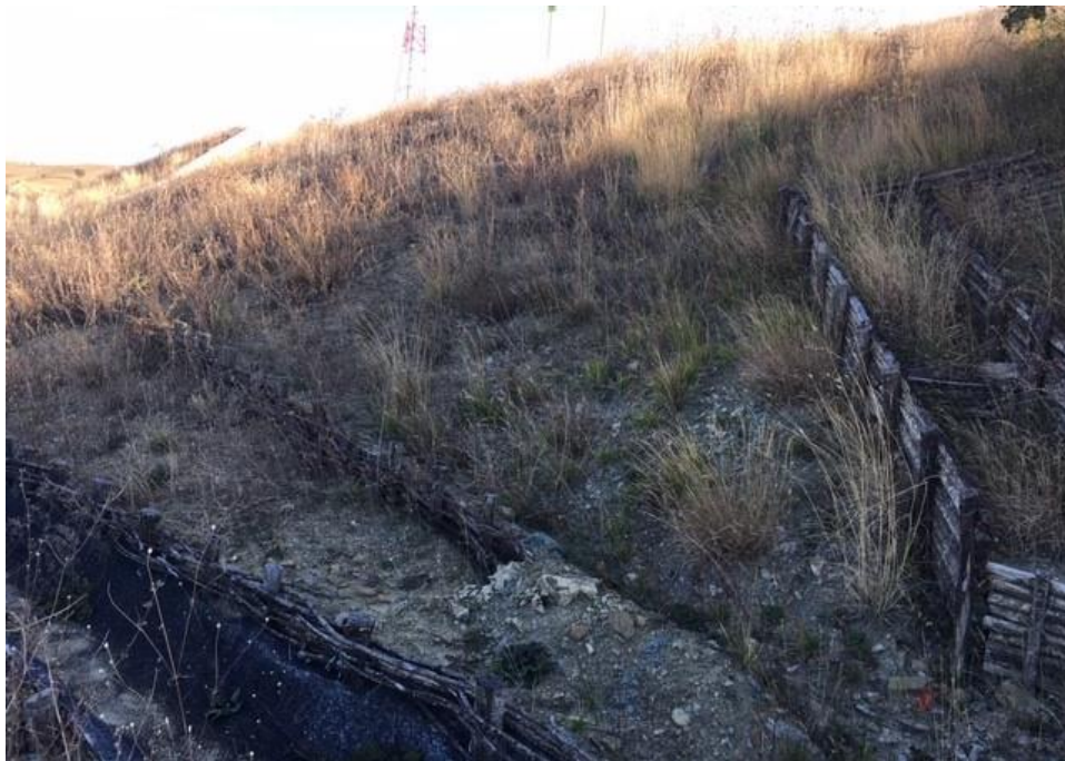
Foto 32 – Attraversamento flowline, particolare delle Fascinate a monte della Strada di accesso
