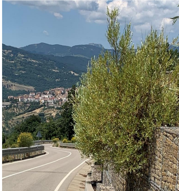
Foto 11 - Strada di accesso, particolare gabbionata
