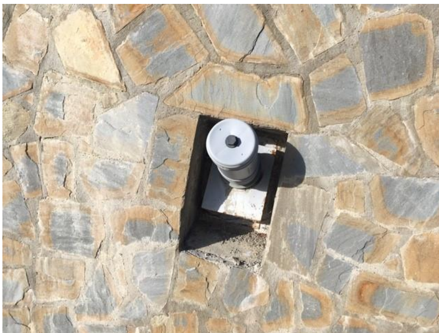
Foto 22 - Particolare nicchia tirante
