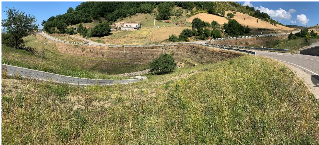
Foto 13 - Rinverdimento terre rinforzate (lungo strada di accesso)
