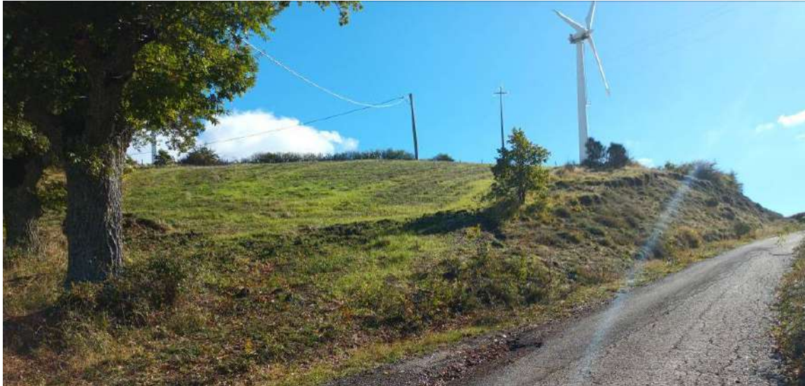
Foto 7 – Strada di accesso e percorso flowline
