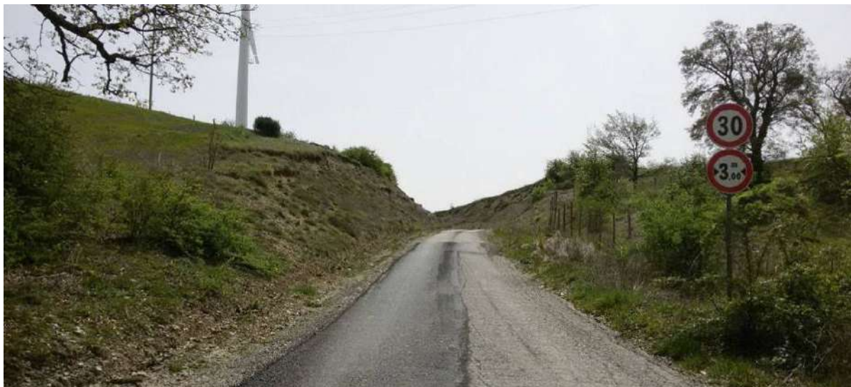
Foto 6 – Strada di accesso e percorso flowline
