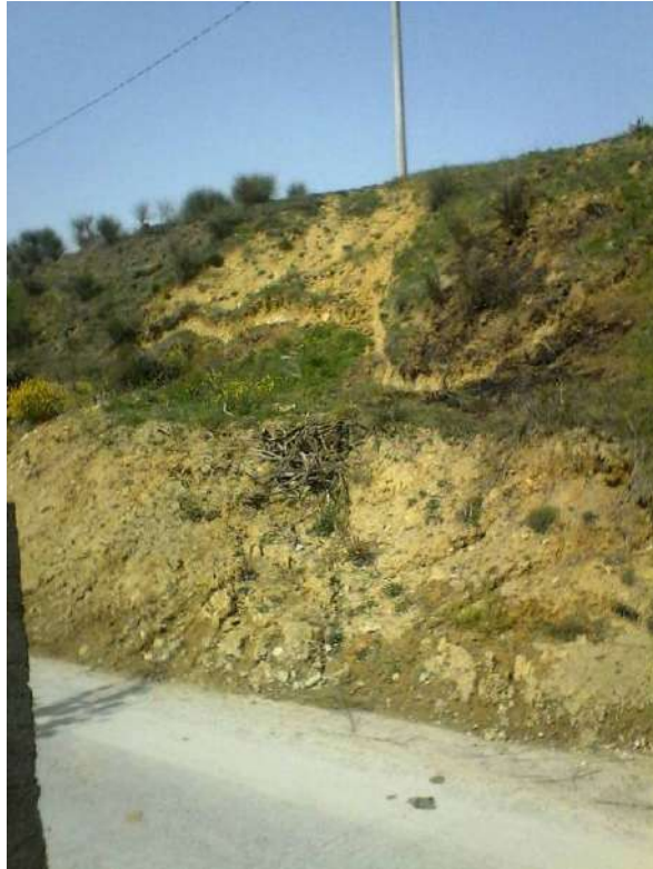
Foto 8 – Frana di tipo scorrimento rototraslazionale
