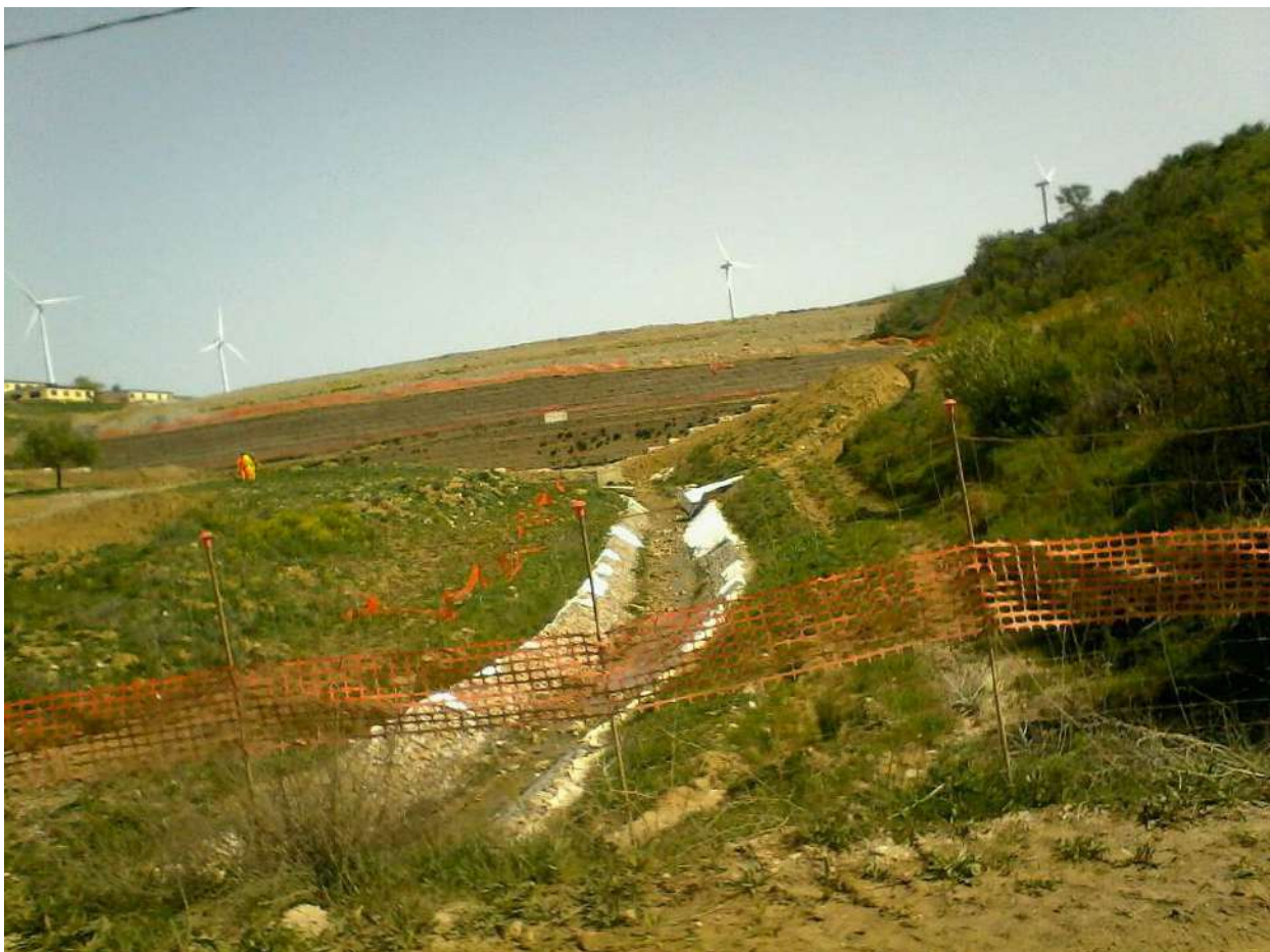
Foto 13 – Opera di sistemazione fosso di ruscellamento
