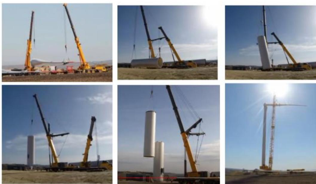
Figura 11. Schema delle fasi di sollevamento dei componenti dell'aerogeneratore. Cantiere impianto della Società proponente Asja Ambiente Italia S.p.A. (Fonte: [https://www.youtube.com/watch?v=dEe5\\_RGTGgY](https://www.youtube.com/watch?v=dEe5_RGTGgY))
