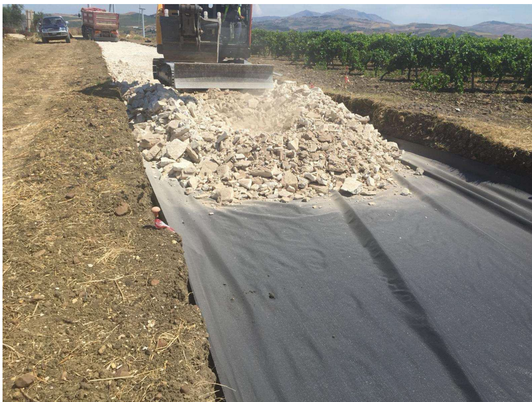
Fig.3. Posa in opera di geocomposito e fondazione stradale
