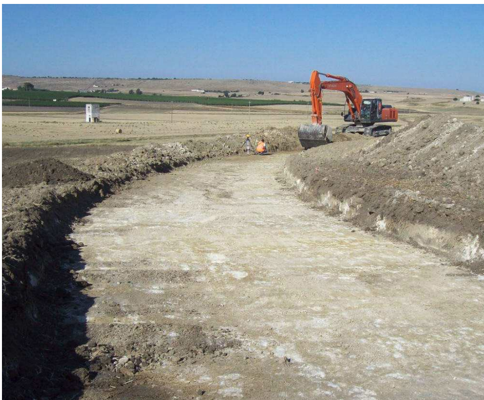
Fig.2. Apertura sede stradale
