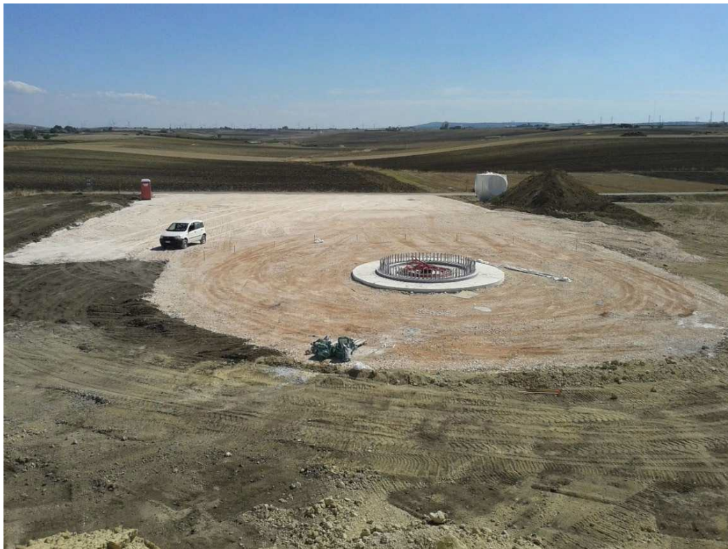
Fig.6. Piazzola di montaggio in fase di cantiere
