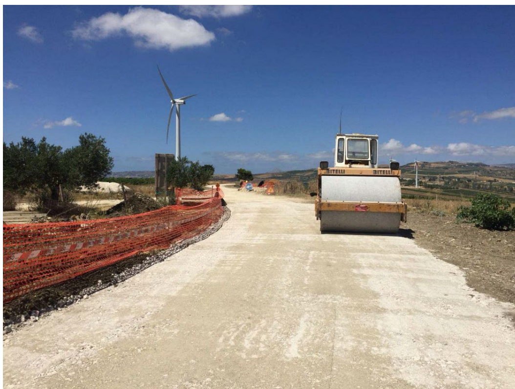
Fig.4. Compattazione strato di finitura
