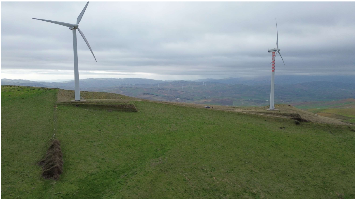
Figura 8 – Report fotografico dello stato di fatto
