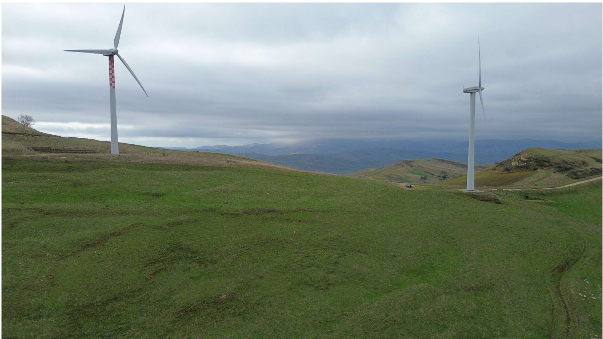
Figura 9 – Report fotografico dello stato di fatto
