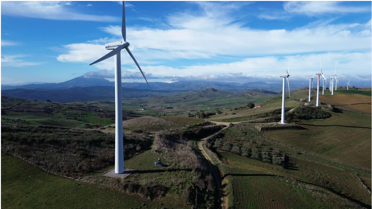
Figura 6 – Report fotografico dello stato di fatto
