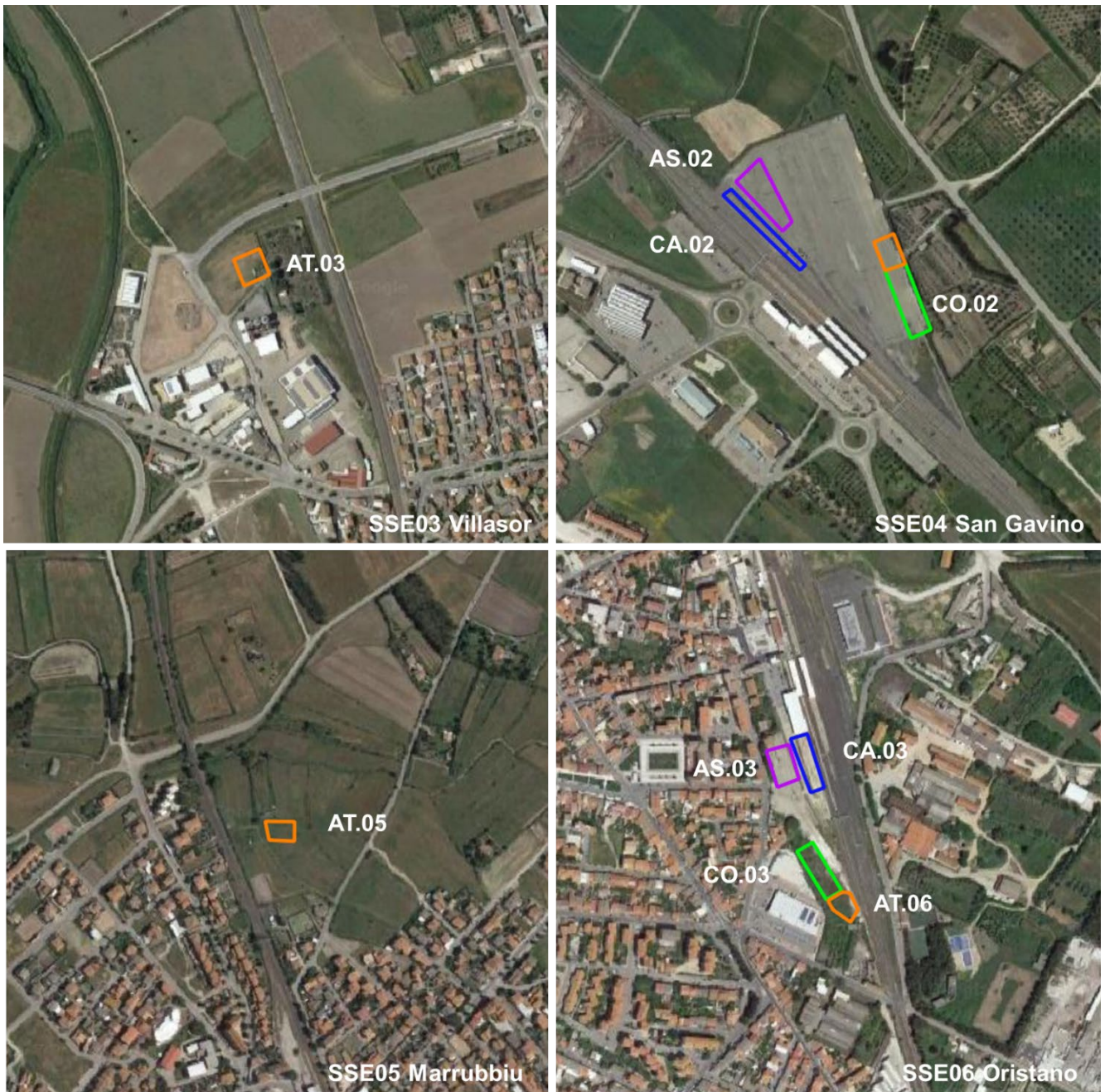
Figura 5 - Aree di cantiere fisso: contesto localizzativo.
