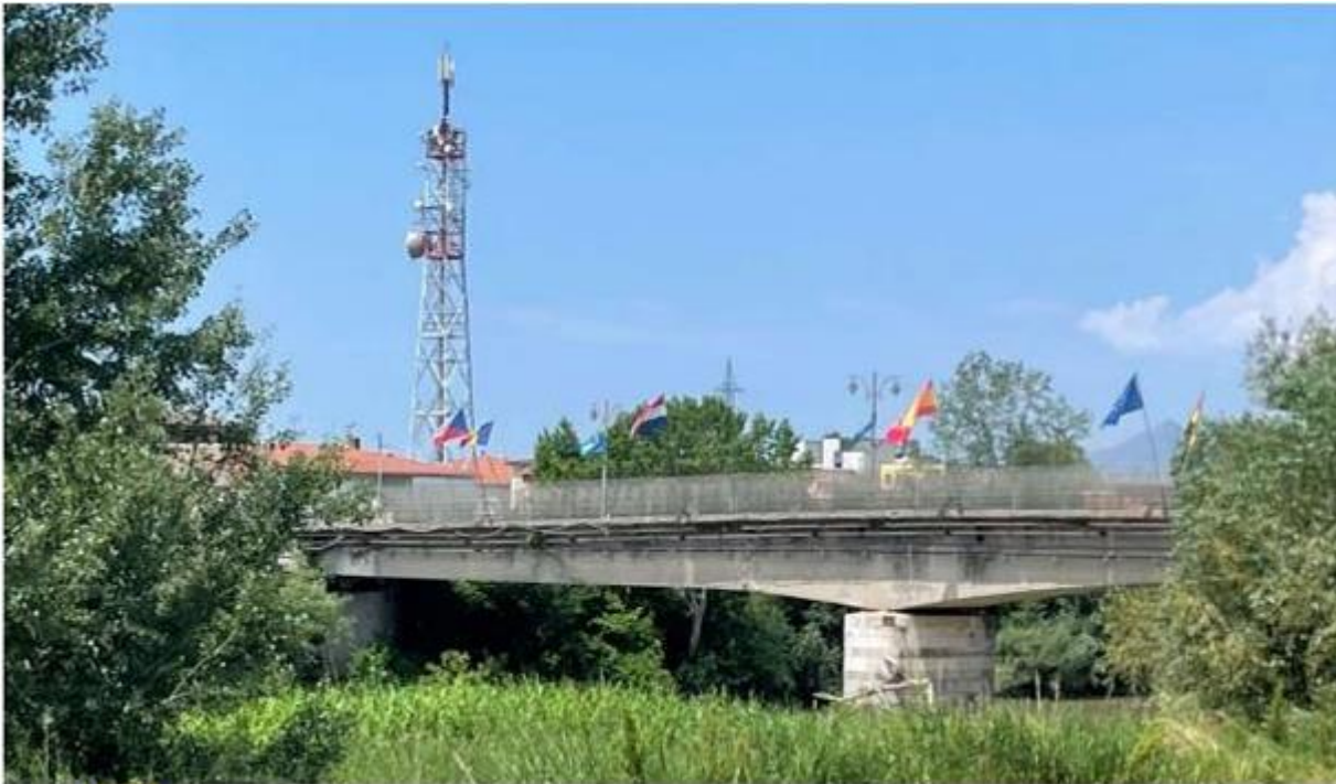
Figura 60. vista Ponte Fiume Volturno Stato di fatto
