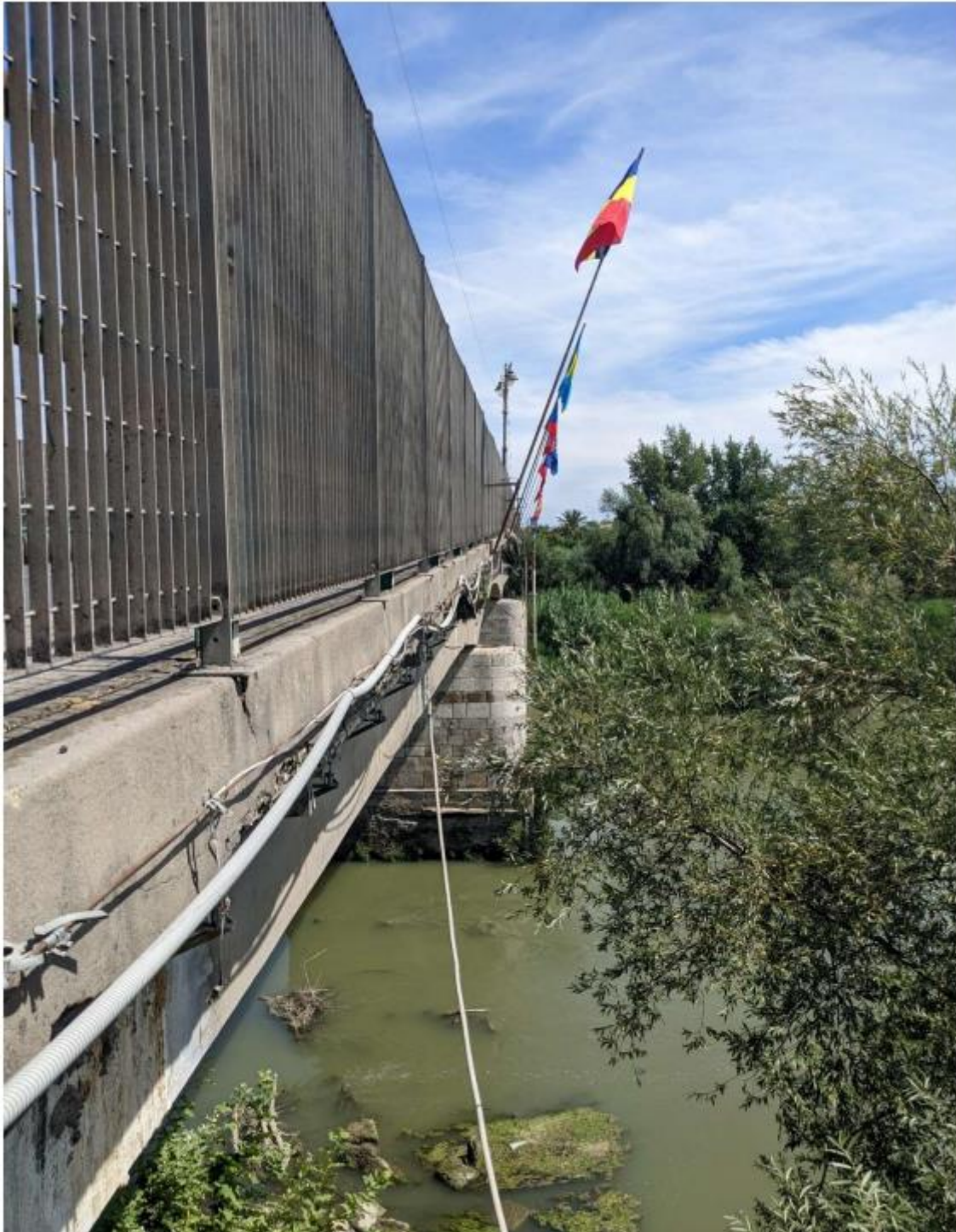
Figura 63. Dettaglio Ponte Fiume Volturno - stato di fatto
