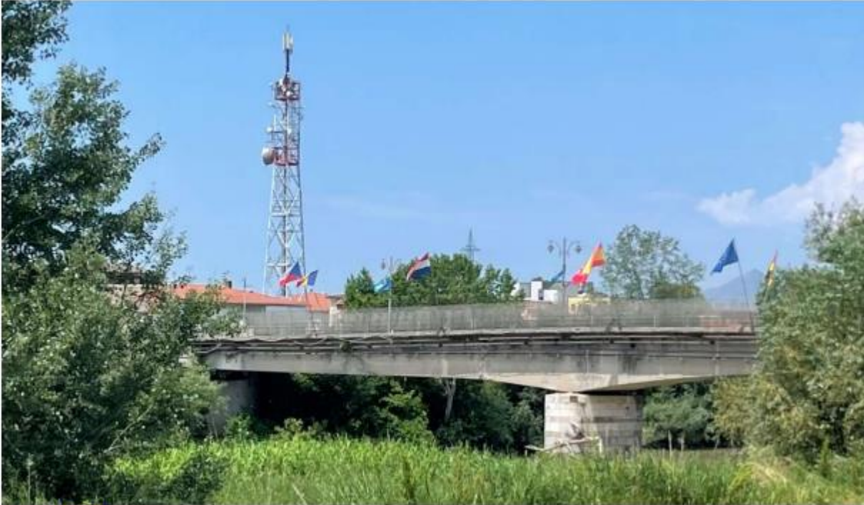
Figura 61. vista Ponte Fiume Volturmo Stato di fatto
