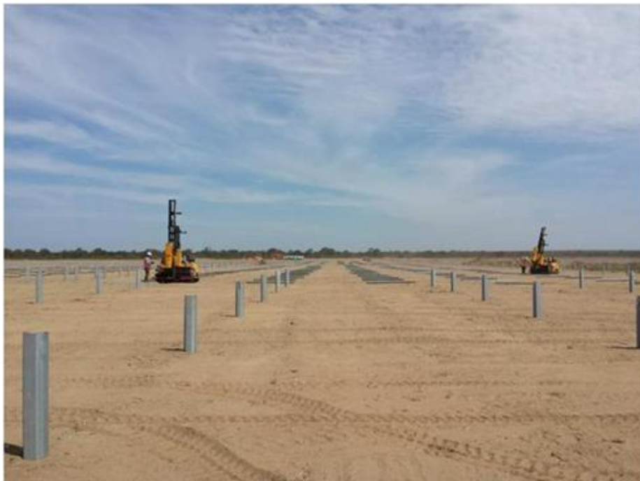
Figura 42. Fase di infissione dei pali con profilo omega (fonte Convert)
