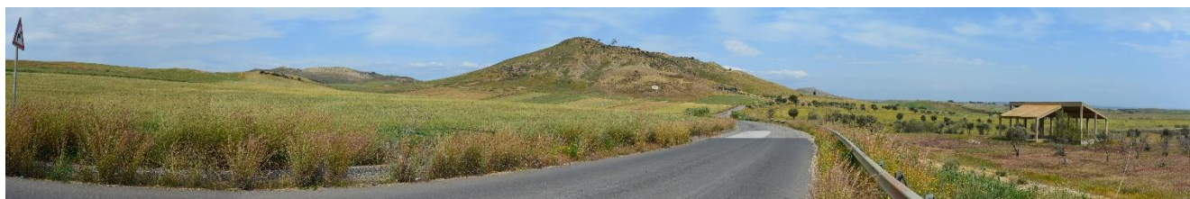
Figura 48 - Stato di fatto del punto di scatto F133
