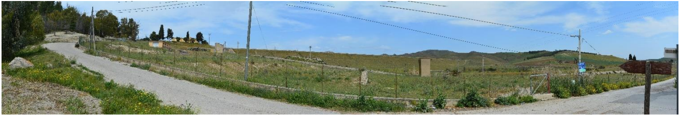
Figura 8 - Stato di fatto del punto di scatto F12
