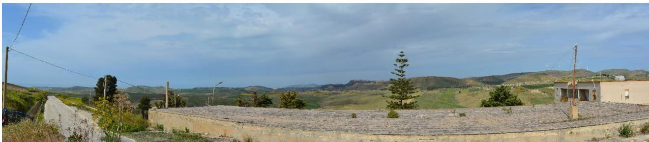
Figura 26 - Stato di fatto del punto di scatto F73
