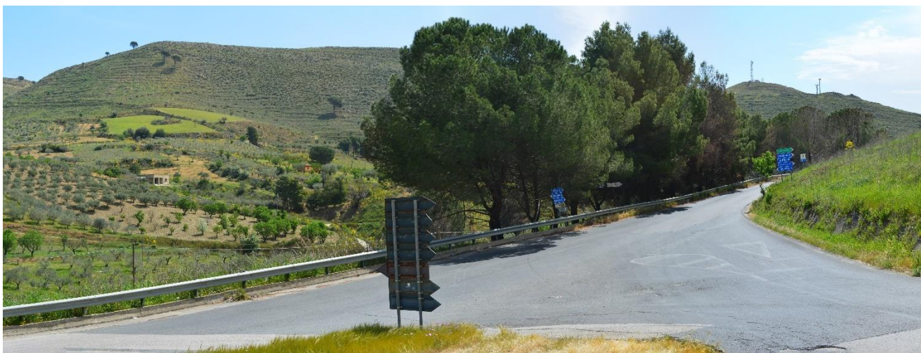
Figura 10 - Stato di fatto del punto di scatto F15
