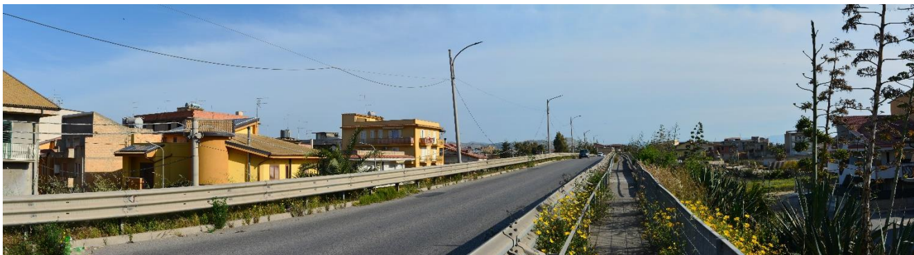
Figura 30 - Stato di fatto del punto di scatto F85
