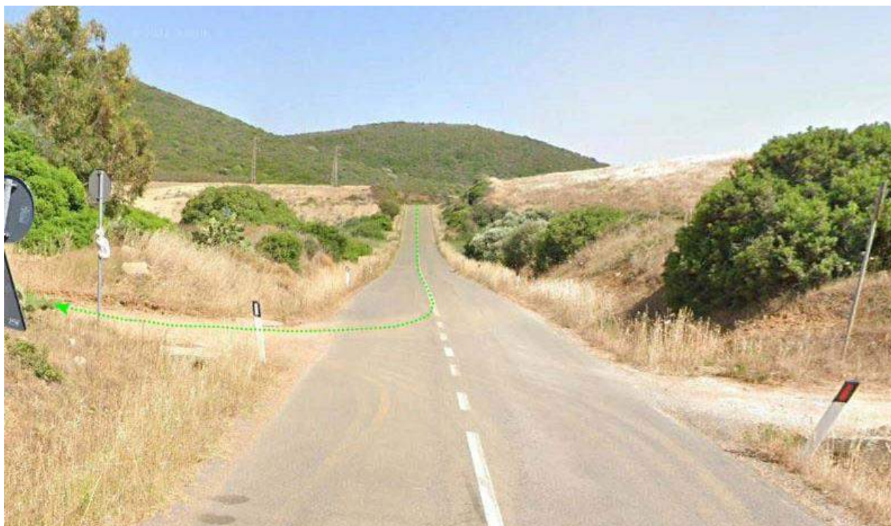
Figura 9.28 Accesso al Cluster Sud dalla strada di collegamento S.S.292 e S.P. 11 in località Sa Prunishedda (direzione sud-est)
