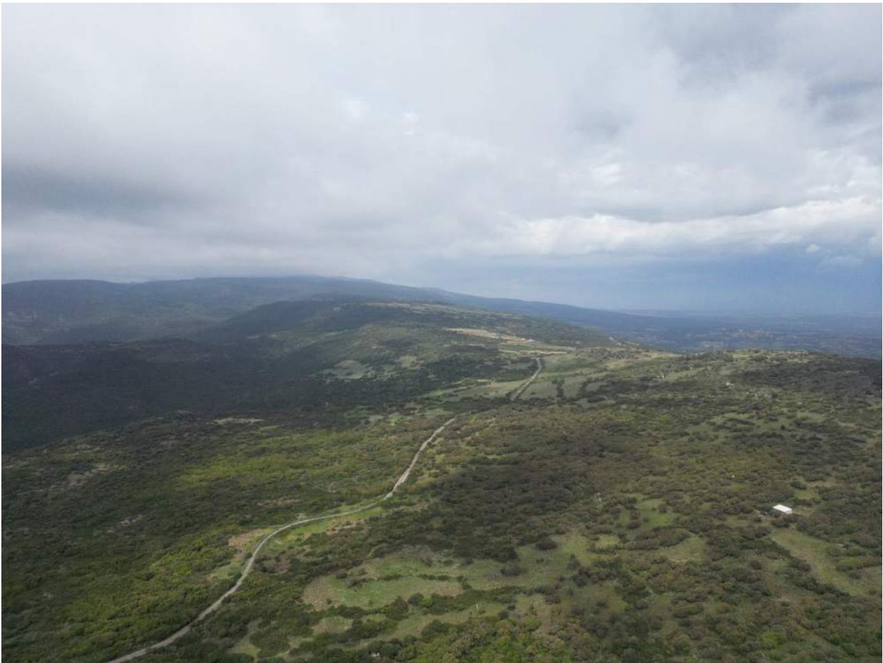
Figura 7.4 – Vista sulla porzione settentrionale e centro-occidentale dell’impianto. Ripresa aerea da sud-ovest verso nord-est
