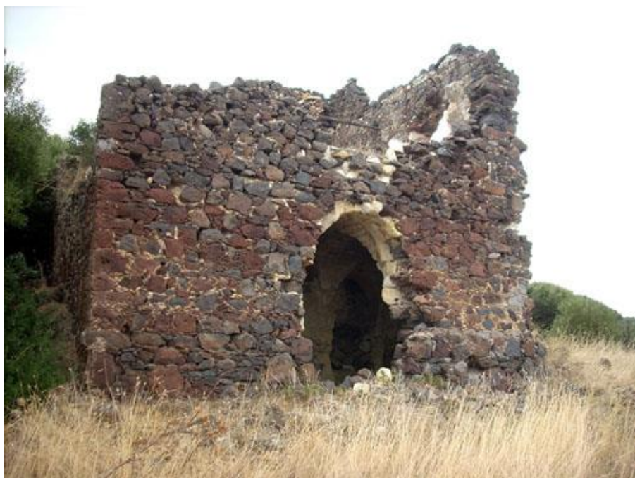
Figura 8.2 - Ruederi dell'edificio di Su Palatu, miniera a nord di Su Enturgiu (Fonte: minieredisardegna.it)
