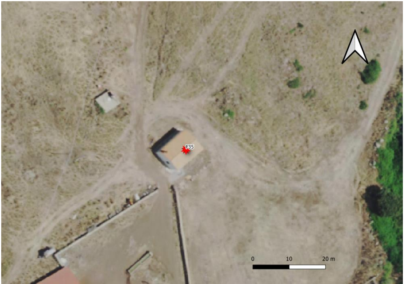
Figura 6.3 – Fabbricato F35 (Vista zenitale). In evidenza la ridotta superficie fenestrata presente nel prospetto sudovest
