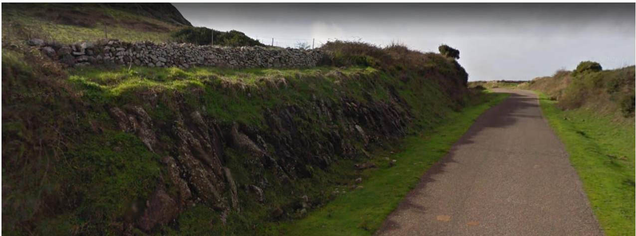
AFFIORAMENTO BASALTICO FRATTURATO IN UN TAGLIO STRADALE DELLA VIABILITÀ DI ACCESSO SITI
