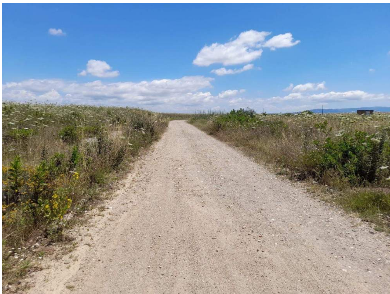
Figura 139: P12 nuovo verso SE
