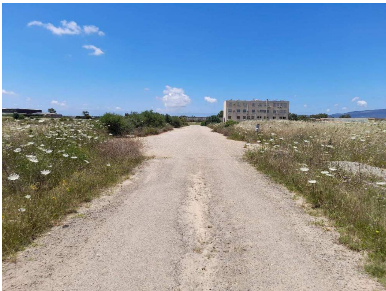
Figura 137: P12 nuovo verso NO
