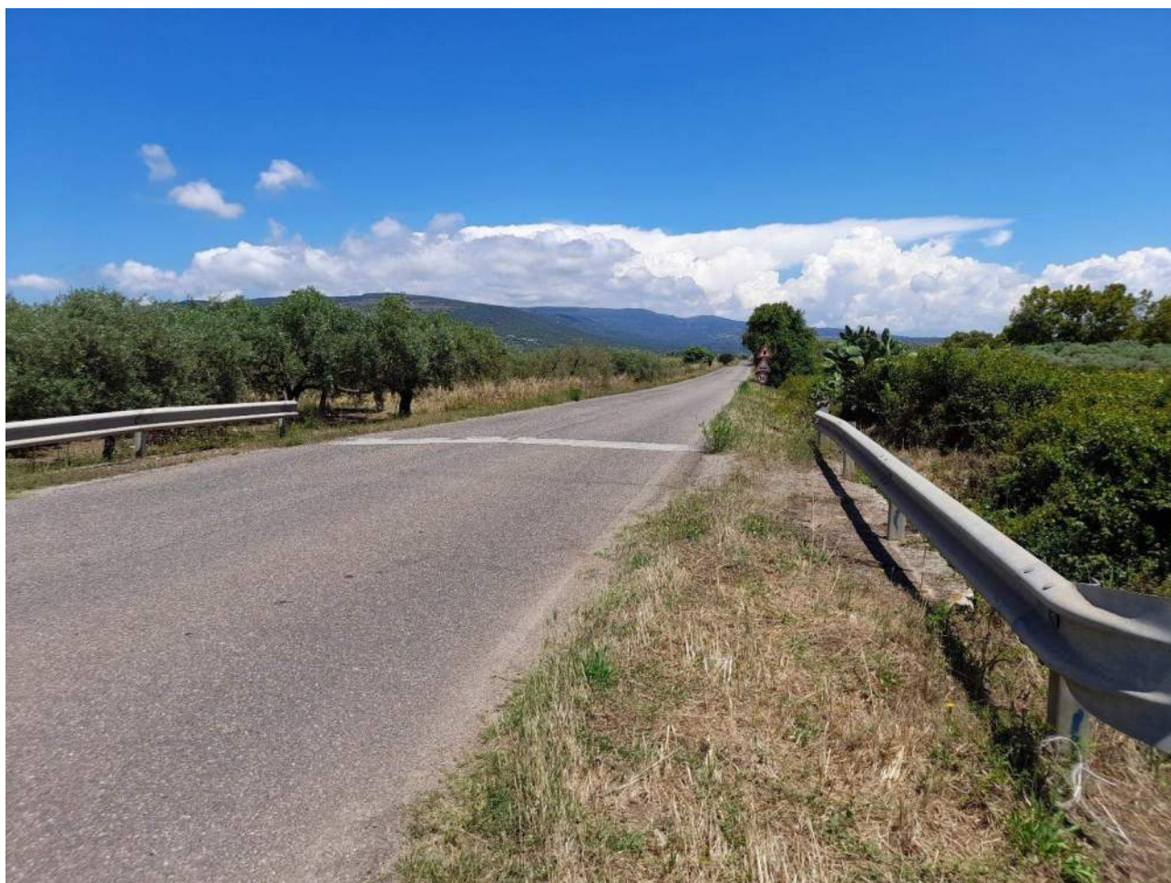
Figura 125: P8 nuovo verso NE
