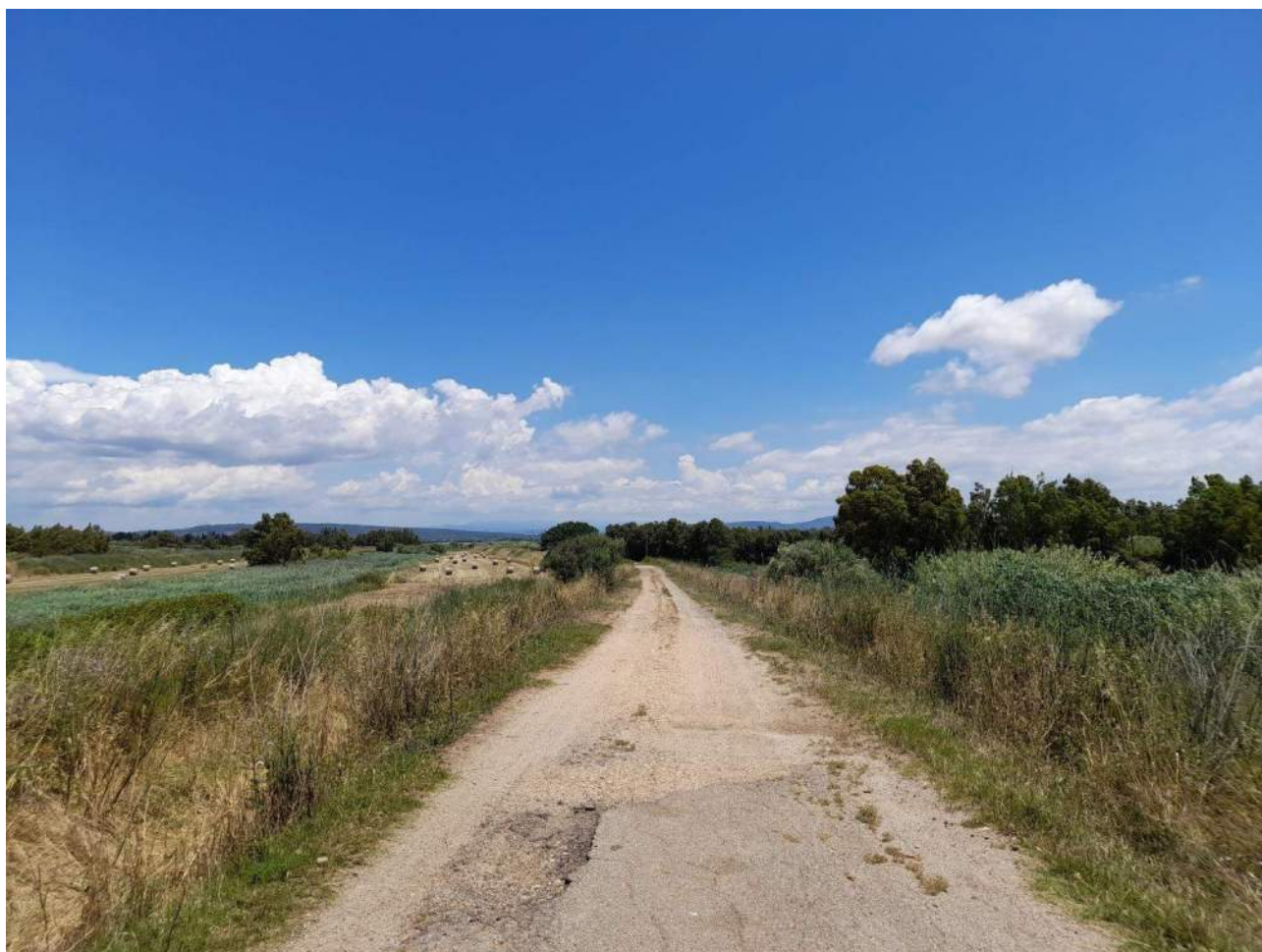
Figura 133: P10 nuovo verso E
