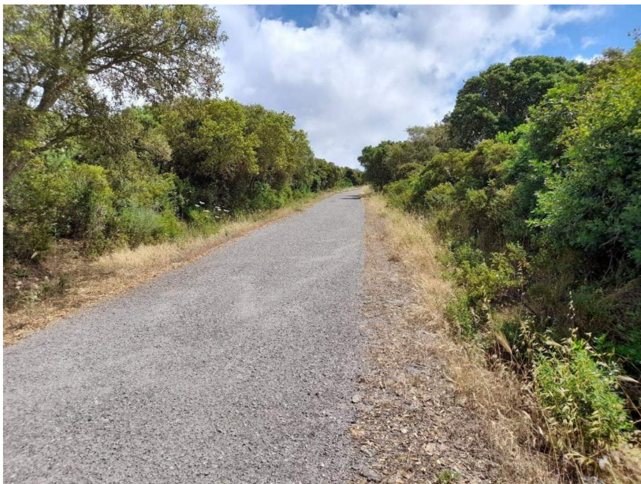
Figura 105: P3 nuovo verso NE
