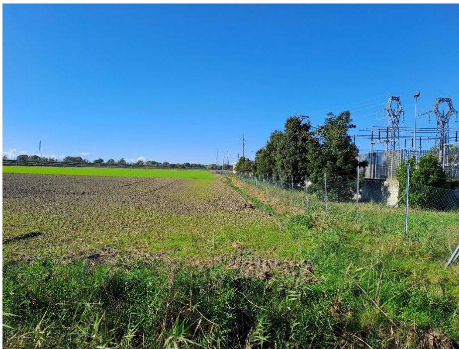
Figura 2 - Vista verso Ovest da Via Trotta della SE 132 kV Alfonsine SC
