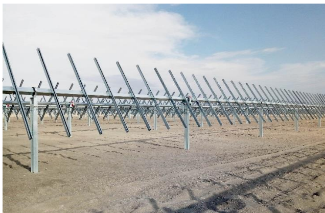
Rappresentazione della struttura di supporto – vista frontale
