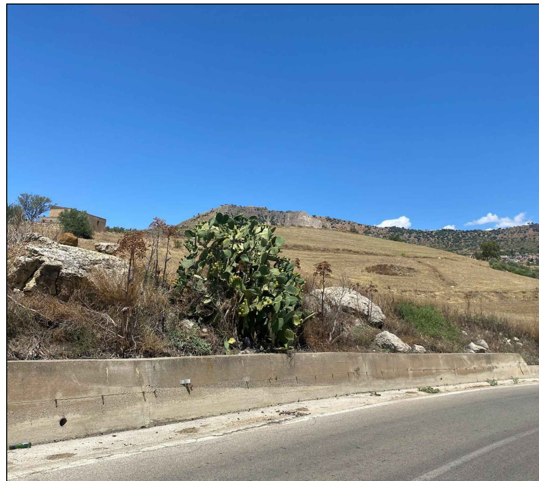
PERCORSI PANORAMICI - NORMALE ACCESSIBILITA' PUNTO 4: CORRISPONDENTE ALLA SP25ii ( VERSO NORD) - ANTE OPERAM
