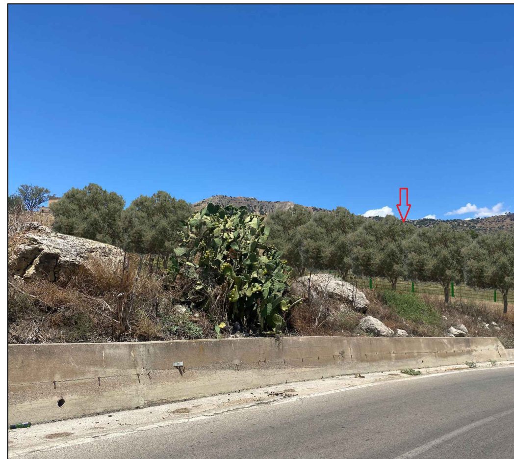
PERCORSI PANORAMICI - NORMALE ACCESSIBILITA' PUNTO 4: CORRISPONDENTE ALLA SP25ii ( VERSO NORD) - POST OPERAM
