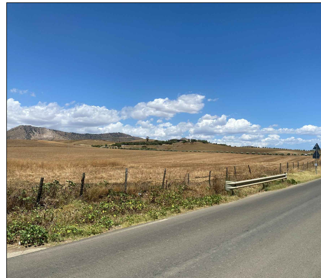
REGIE TRAZZERE PUNTO 8: RT N. 461, COINCIDENTE CON LA SS288 - NORMALE ACCESSIBILITA' (VERSO NORD-EST) - POST OPERAM Nessun impianto visibile
