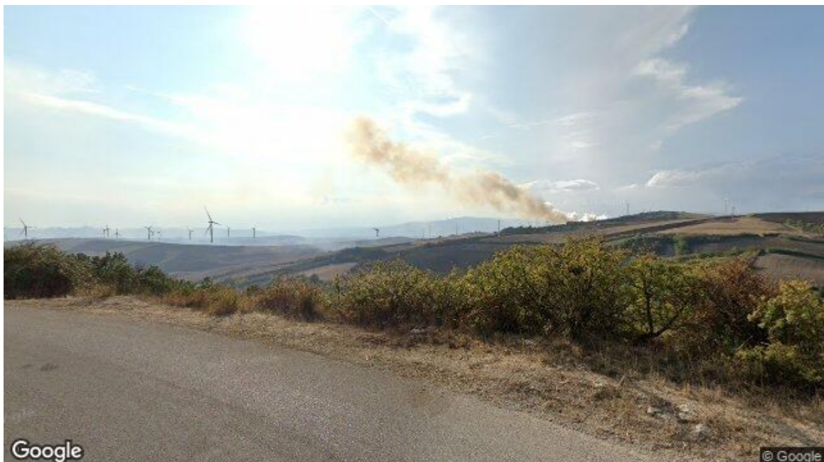
Figura 35 - ETG-1 e WTG-2 vista da SP-58
