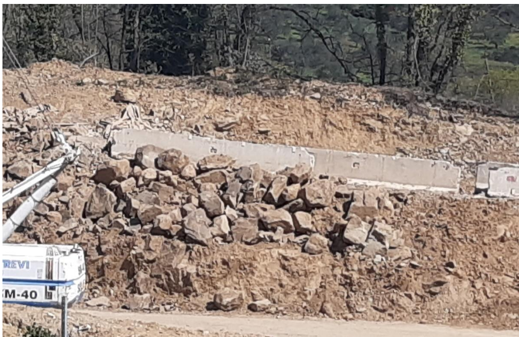
Figura 20 Accumulo di blocchi arenacei rinvenuti durante i vari scavi (scarpata tra l'autostrada A1 esistente ed il tratto in allargamento) (foto 07/2023).
