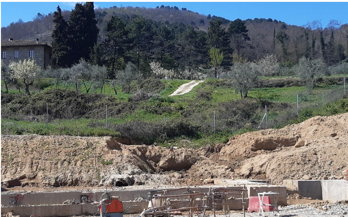
Figura 7-12 –Panoramica del versante in località Piscinale visto da Est. In primo piano la testa della paratia di valle, in prossimità dell'opera di raccolta delle acque superficiali provenienti dal versante (foto 07/2023)
