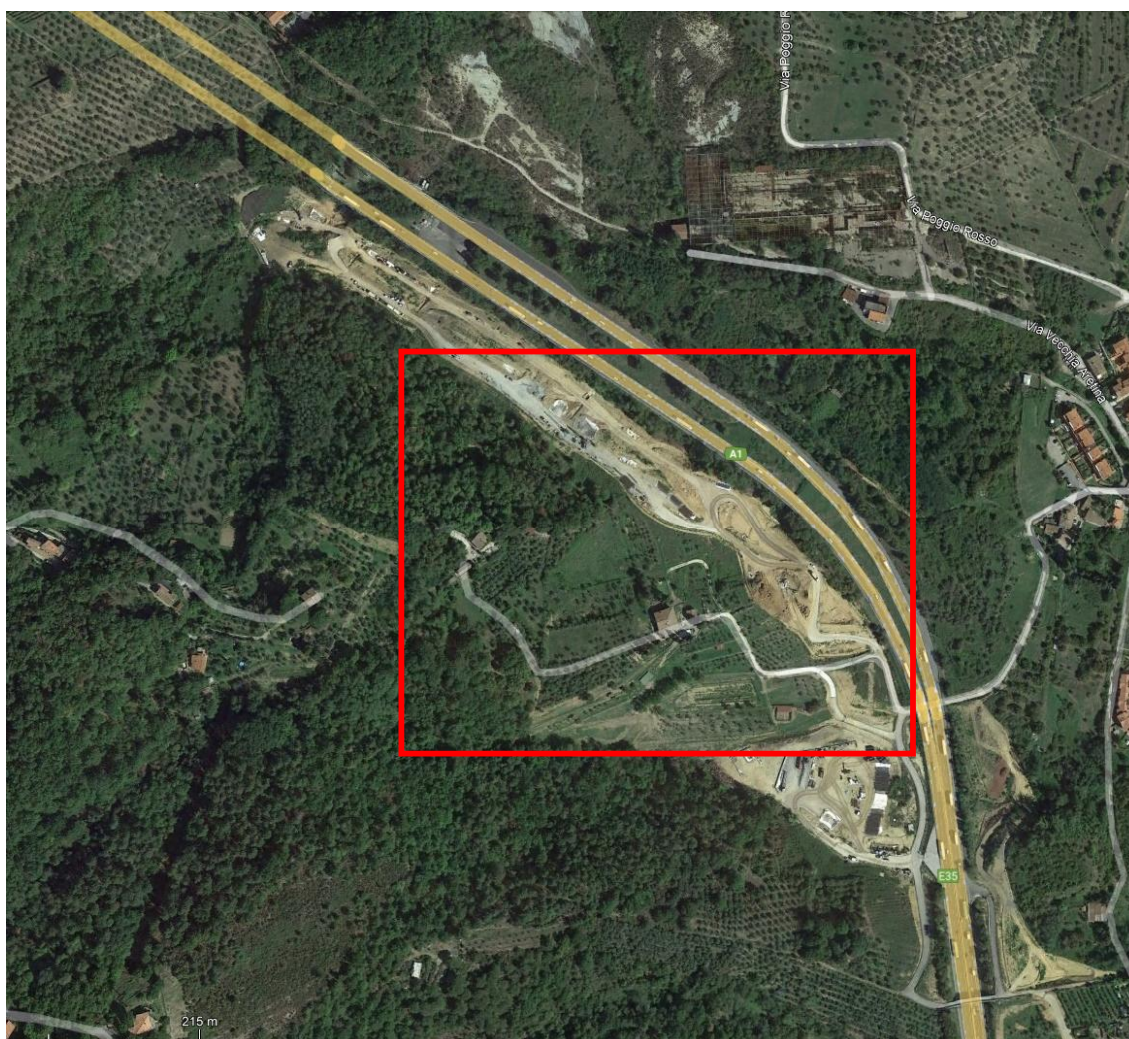
Figura 2-1 - Inquadramento da satellite dell'area di interesse (Google Earth, foto 08/2022). E' visibile l'area di cantierizzazione relativa all'ampliamento a terza corsia
