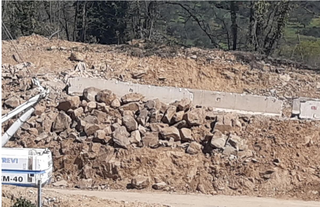
Figura 7-10 – Accumulo di blocchi arenacei rinvenuti durante i vari scavi (scarpata tra l'autostrada A1 esistente ed il tratto in allargamento) (foto 07/2023).
