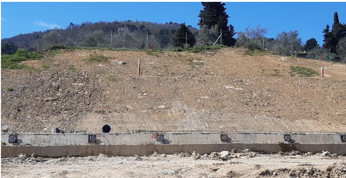
Figura 7-14 –Vista da basso del taglio eseguito nella parte terminale del versante, circa in asse con lo strumento inclinometrico MC51-N1 posto più a monte (foto 07/2023). E’ visibile in primo piano la testa della paratia di valle
