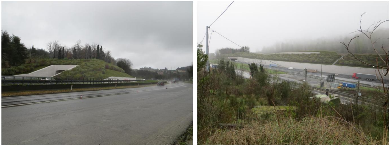
Figura 6.11: Foto inserimenti del rimodellamento morfologico in corrispondenza degli imbocchi della galleria artificiale
