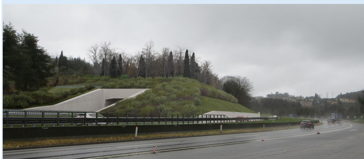
Nuova figura 21 – Fotoinserimento della galleria artificiale finita (vista dalla piazzola di emergenza della carreggiata nord)
