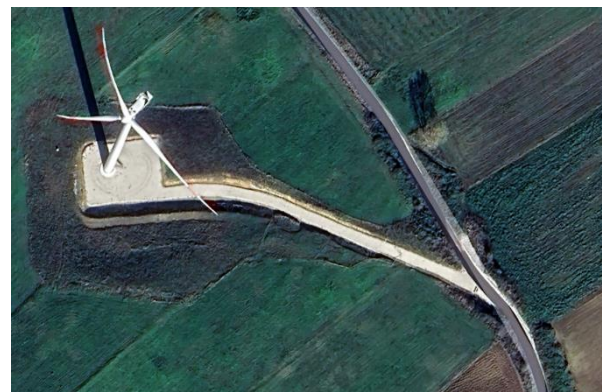
Piazzola in fase di esercizio
