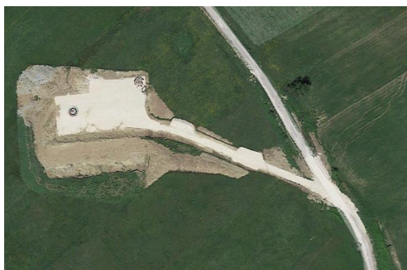
Piazzola in fase di cantiere
