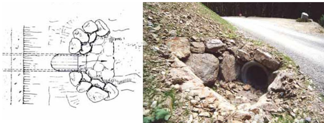
Figura 6-15: Pozzetti in legname e in massi (fonte: "Viabilità forestale regionale" Bortoli, P.L. 2001).
