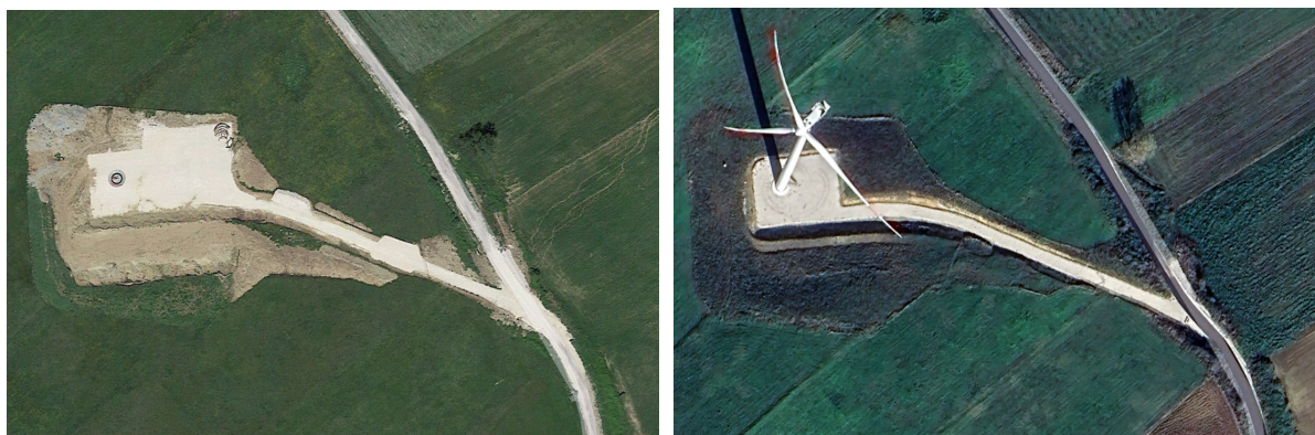
Piazzola in fase di cantiere
