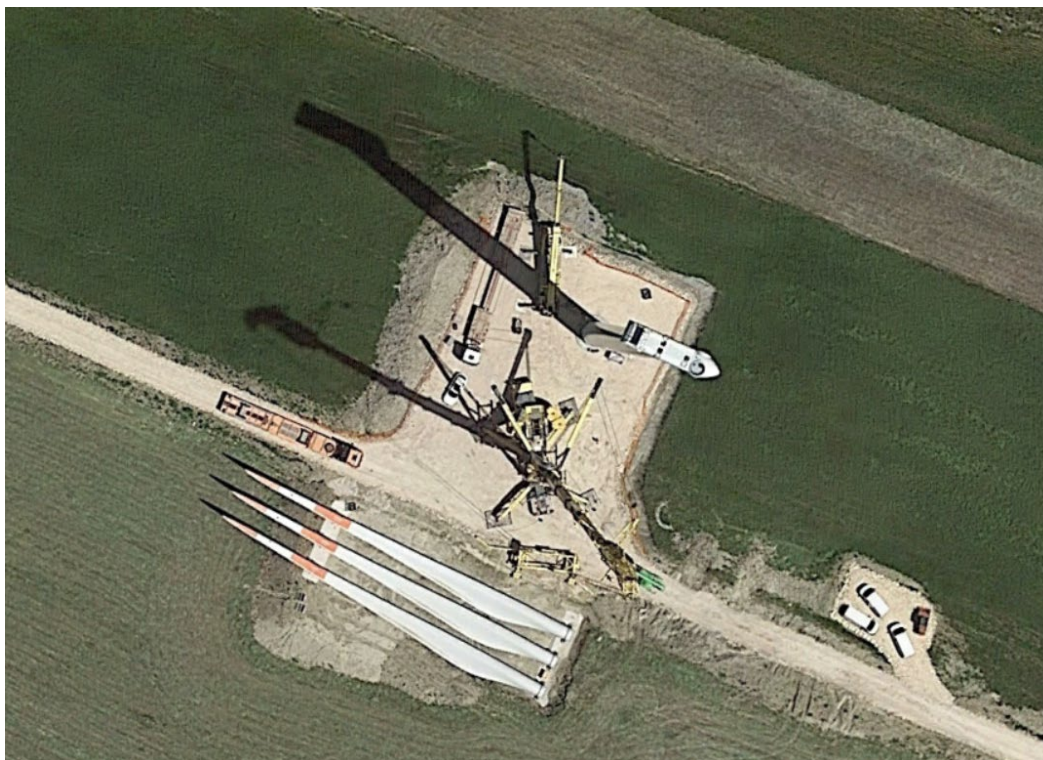
Figura 2.6 – esempio di piazzola in fase di costruzione
