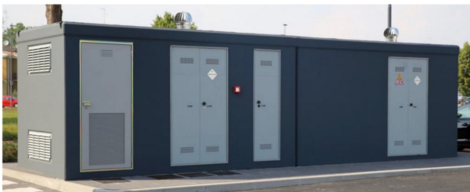
Figura 2.9 – tipologiche cabine elettriche
