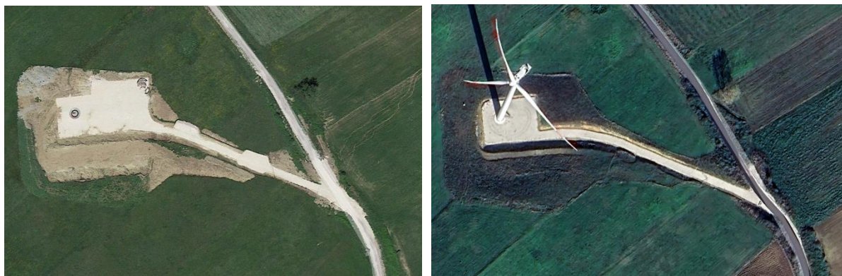
Piazzola in fase di cantiere
