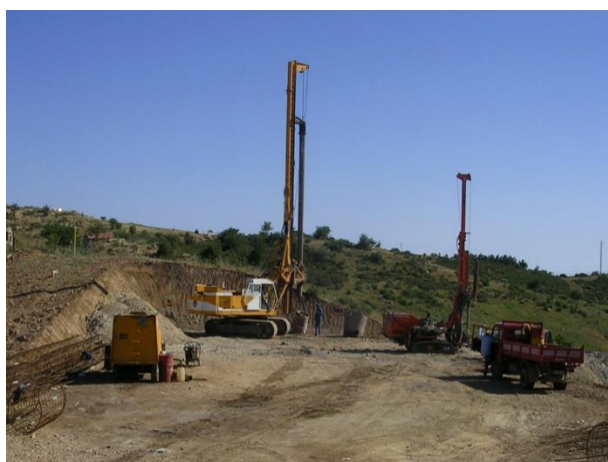
Realizzazione pali trivellati
