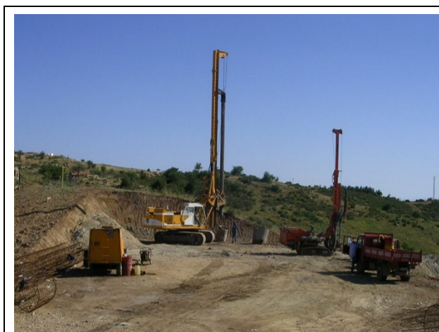
Realizzazione pali trivellati
