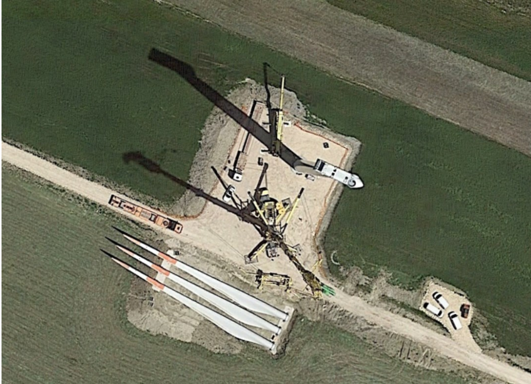
Figura 3.18: esempio di piazzola in fase di costruzione
