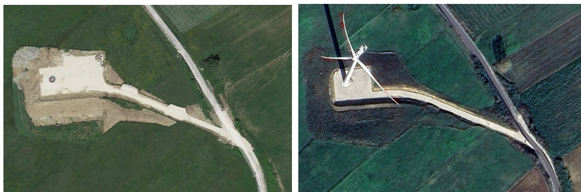
Piazzola in fase di cantiere
