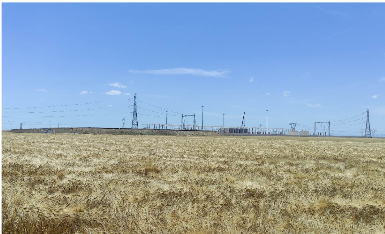
Vista dal terreno su cui verrà realizzata la cabina di consegna 36 kV dell'impianto agrolvoltaico. Sullo sfondo, a poca distanza, è ben visibile la SSE di Terna S.p.A. in costruzione.
