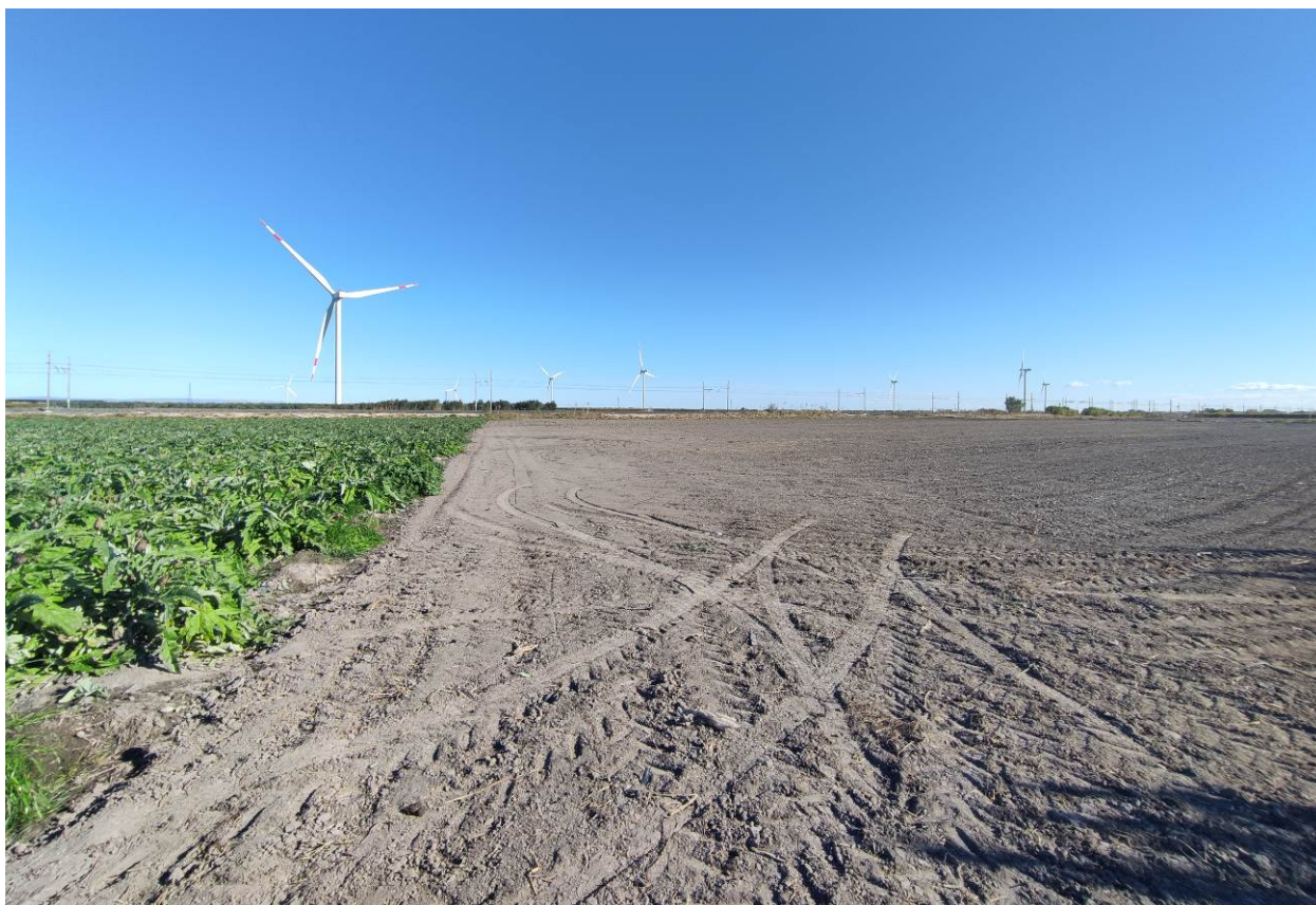
Vista, in direzione Nord, del terreno interessato dalla realizzazione dell'Area 5 dell'impianto agrovoltaico. Sullo sfondo è visibile la linea ferroviaria ed i numerosi aerogeneratori presenti nell'area.
