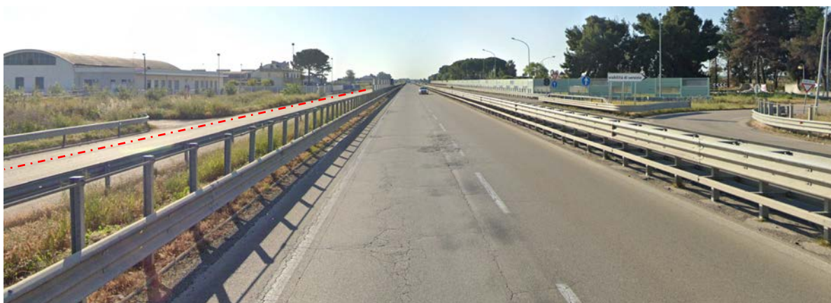
Vista in direzione Sud – Est di due delle quattro corsie che compongono la carreggiata della strada statale SS16 Adriatica; sulla destra la strada complanare sulla quale verrà realizzato il cavidotto MT di collegamento tra le aree dell’impianto agrovoltaico (linea tratteggiata in rosso). Tutta l’infrastruttura viaria è stata realizzata sull’area di sedime tutelata del “Regio Tratturo Foggia Ofanto”.
