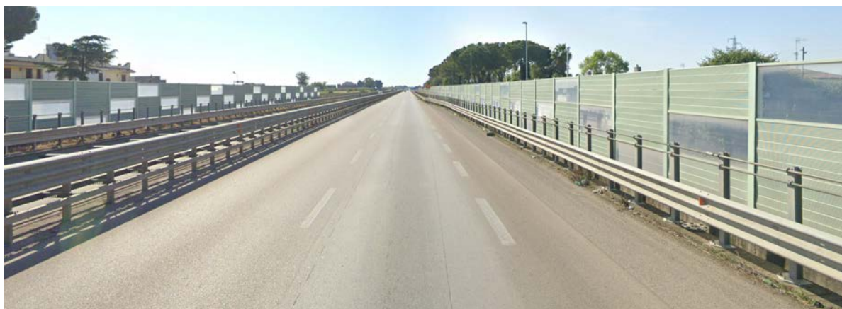
Vista in direzione Sud – Est di due delle quattro corsie che compongono la carreggiata della strada statale SS16 Adriatica; sulla sinistra (oltre la barriera) è presente un’altra strada a due corsie complanare alla SS16 Adriatica. Tutta l’infrastruttura viaria è stata realizzata sull’area di sedime tutelata del “Regio Tratturo Foggia Ofanto”.
