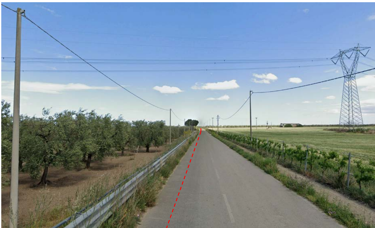
Vista in direzione Sud – Est della strada provinciale SP72 sulla quale verrà realizzato il cavidotto AT, di collegamento tra la sottostazione di trasformazione 30/36 kV e la cabina di consegna 36 Kv. La strada asfaltata
