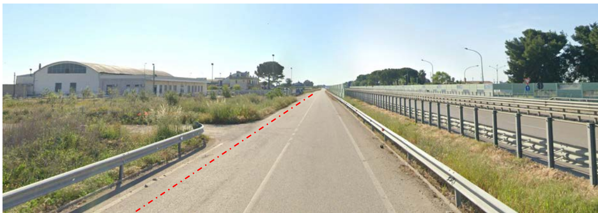
Vista in direzione Sud – Est della strada complanare sulla quale verrà realizzato il cavidotto MT di collegamento tra le aree dell’impianto agrovoltaico (linea tratteggiata in rosso); sulla sinistra sono visibili due delle quattro corsie che compongono la carreggiata della strada statale SS16 Adriatica. Tutta l’infrastruttura viaria è stata realizzata sull’area di sedime tutelata del “Regio Tratturo Foggia Ofanto”. Coordinate scatto (WGS84/UTM 33N): 564554 m E, 4575352 m N.
