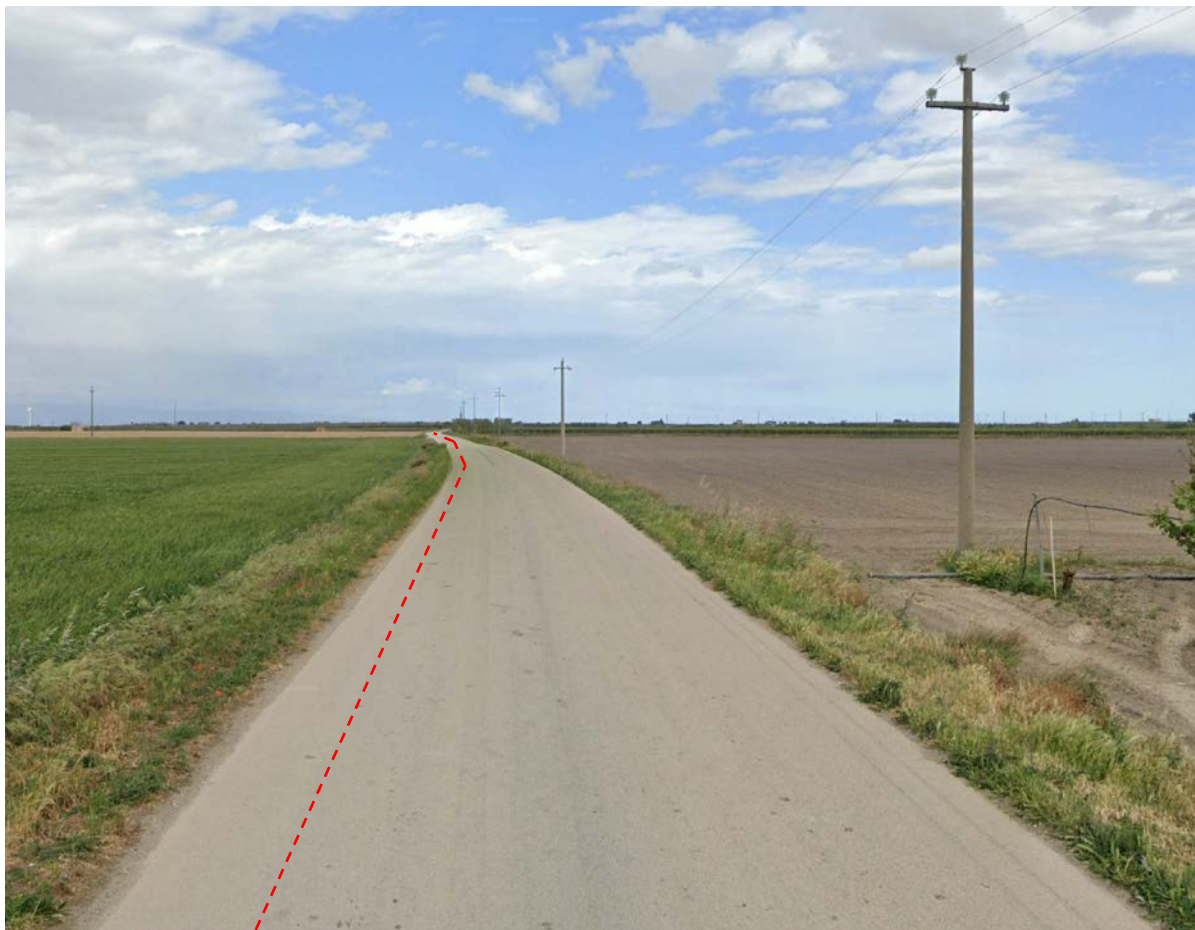
Vista in direzione Nord – Est della strada provinciale SP68 sulla quale verrà realizzato il cavidotto AT, di collegamento tra la sottostazione di trasformazione 30/36 kV e la cabina di consegna 36 Kv (linea tratteggiata in rosso). La strada asfaltata è stata realizzata sull'area di sedime tutelata del "Regio Tratturello Salpitello di Tonti Trinitapoli". Coordinate scatto (WGS84/UTM 33N): 568709 m E, 4576204 m N.
