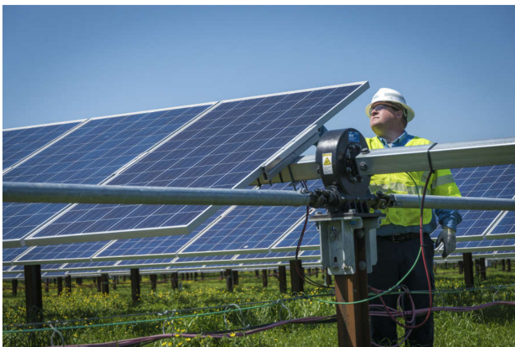
Figura 37: immagine esempio operazioni di manutenzione
