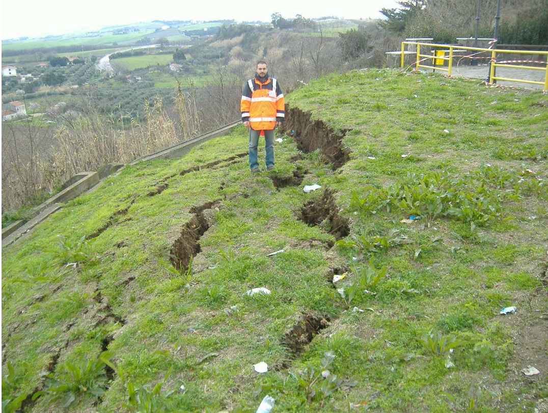
FOTO1: FRATTURE SUL CIGLIO DELLA SCARPATA DI FRONTE LA VECCHIA CHIESA IN PETACCIATO
