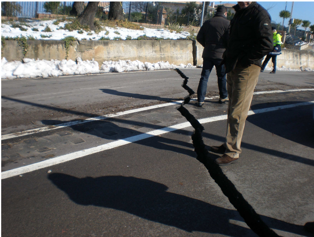
FOTO 9: FRATTURA CENTIMETRICA SULLA S.P. LITORANEA
