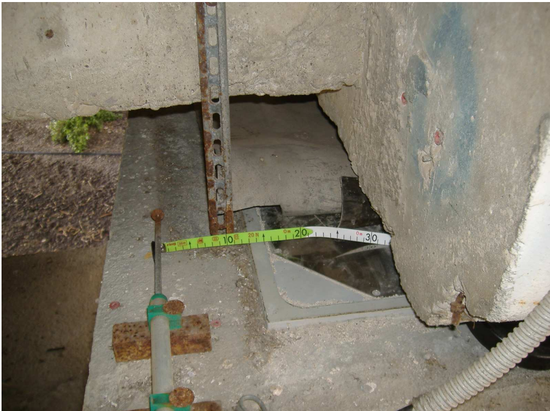
FOTO 21a: VIADOTTO CACCHIONE - SPOSTAMENTO DI UN APPOGGIO MULTIDIREZIONALE
