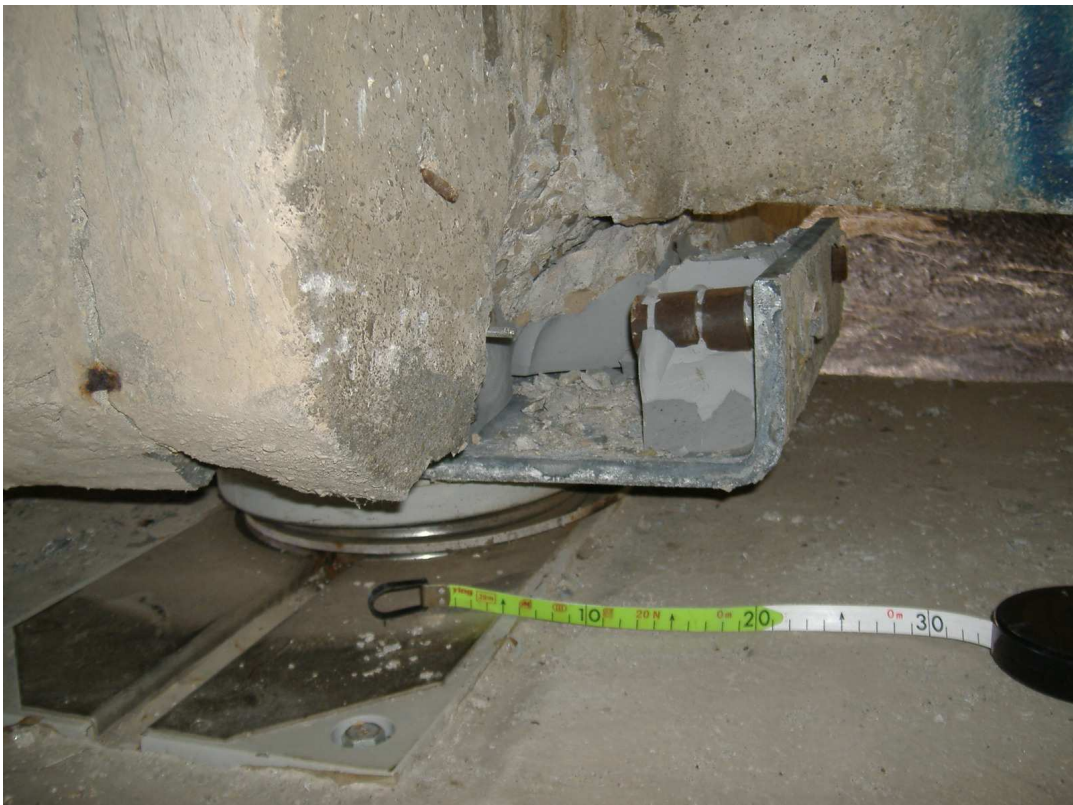
FOTO 21c: VIADOTTO CACCHIONE - SPOSTAMENTO DI UN APPOGGIO UNIDIREZIONALE
