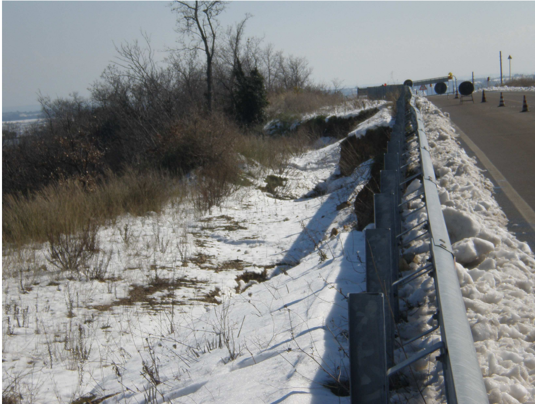
FOTO 8: LOCALITÀ VACCARECCIA – LESIONE LUNGO LA STRADA
