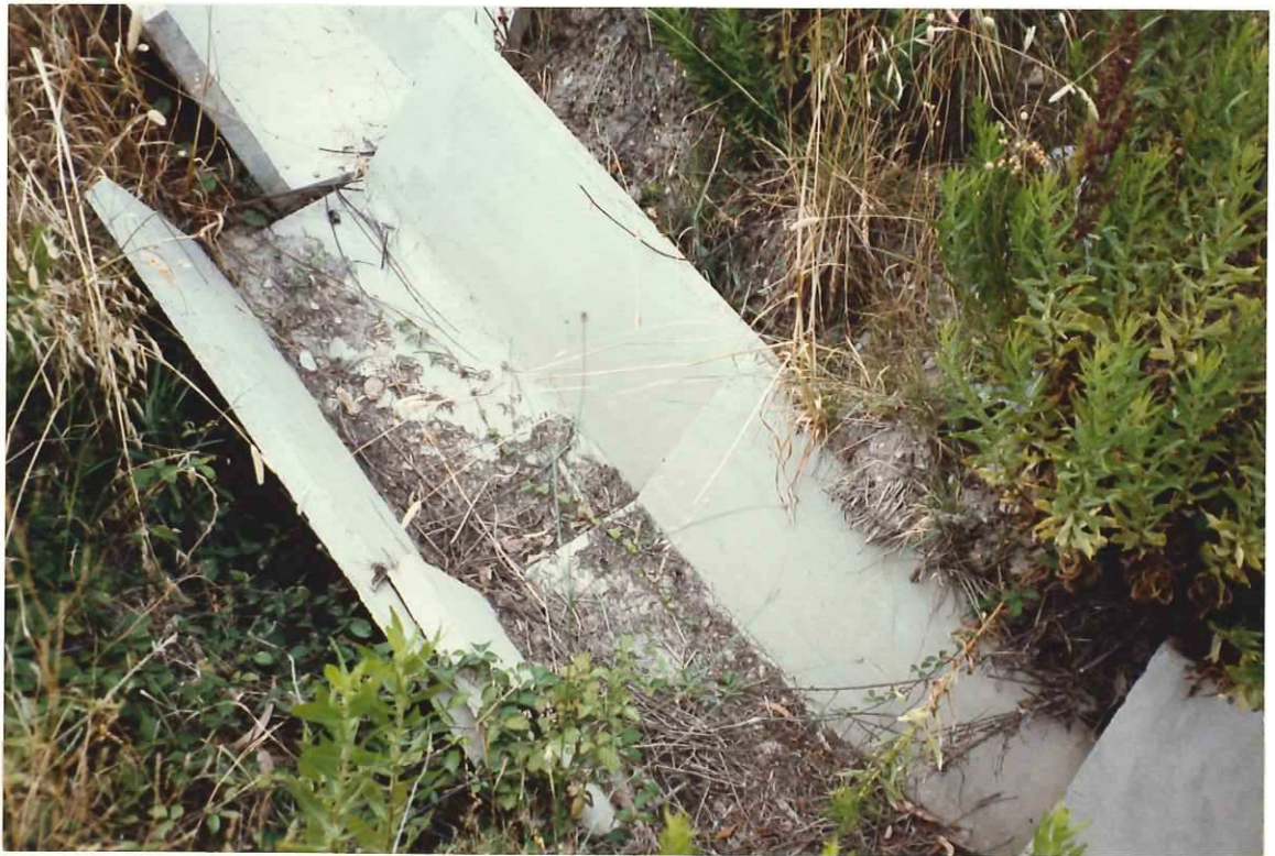
FOTO 16: CANALETTA VICINANZE VIADOTTO CACCHIONE
