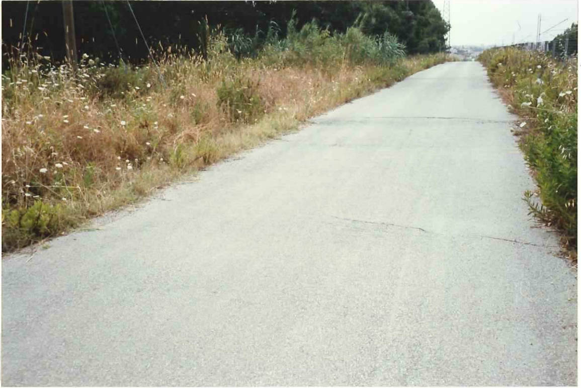
FOTO 17: STRADA VICINALE A VALLE DEL VIADOTTO CACCHIONE
