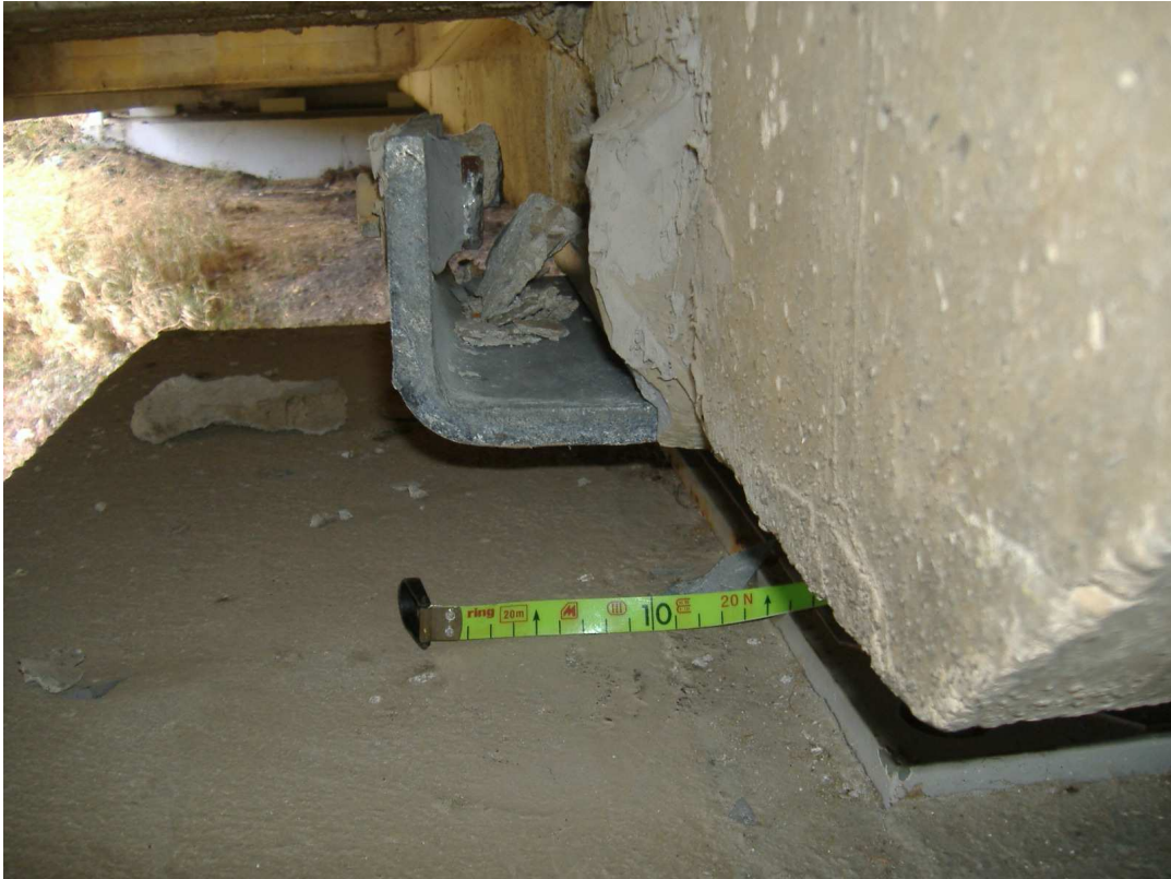
FOTO 21b: VIADOTTO CACCHIONE - SPOSTAMENTO DI UN APPOGGIO UNIDIREZIONALE
