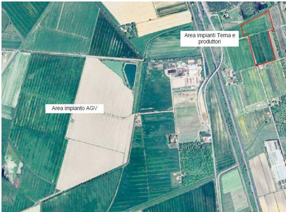
Figura 33: Localizzazione della stazione AT (in alto a destra).
