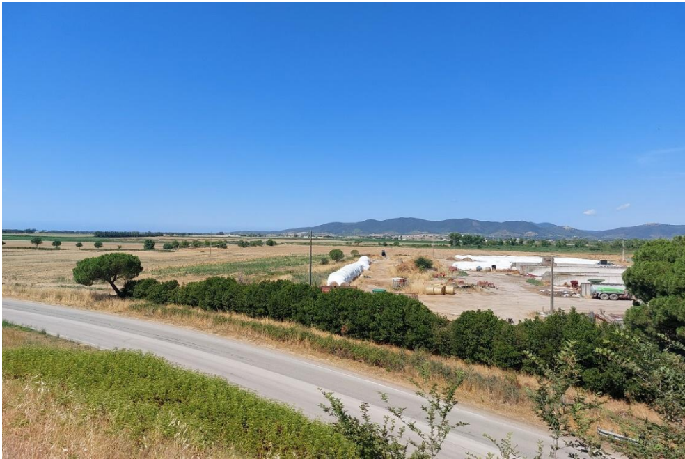
Figura 32-Visuale 6 ante operam dal viadotto della SP152
