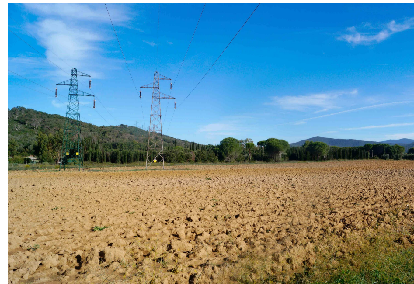
VISUALE 2 STAZIONE UTENZE - STATO ANTE-OPERAM
