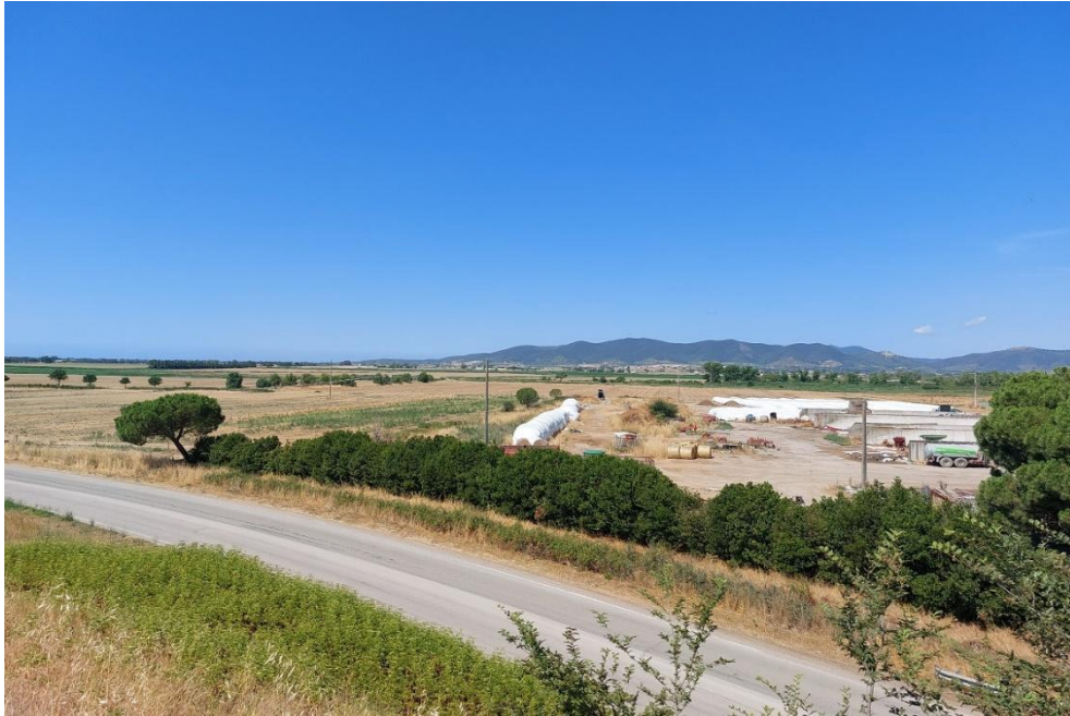
Figura 40 Visuale 6 ante operam dal viadotto della SP152.
