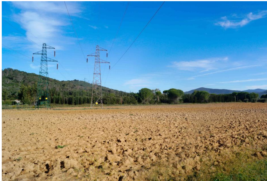
Figura 47 Veduta (2) ante operam del sito dove sarà installata la stazione utenze dalla Strada Provinciale dello Sbirro.
