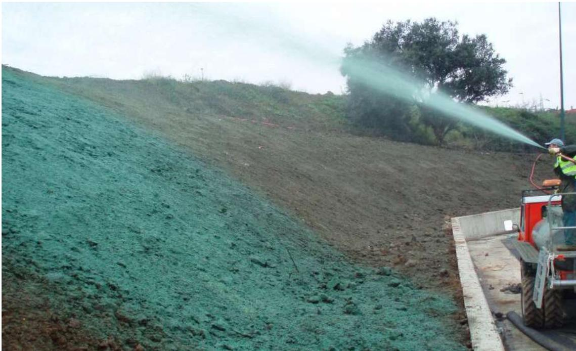
*Figura 26 - Esempi di applicazioni di idrosemina*
