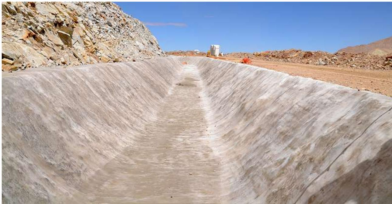
*Figura 30 - Esempio di fosso di guardia in terra*
