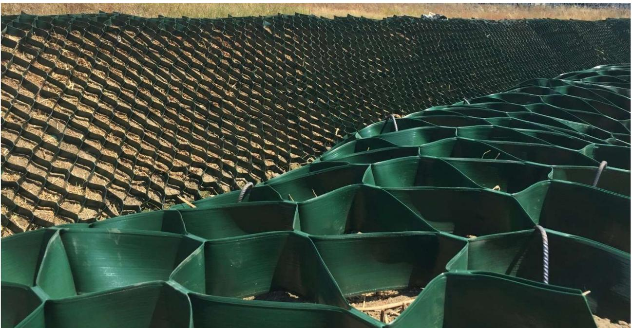
*Figura 29 - Esempio di applicazioni con geocelle*
