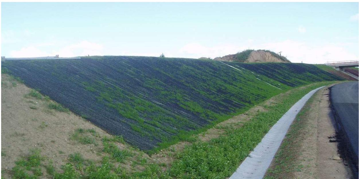
*Figura 27 - Esempi di applicazioni di geostuoie*
