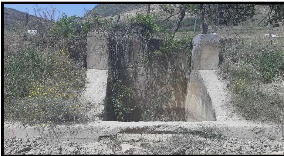
Figura 70 - foto dell'impluvio costituente l'interferenza “Int.81”
