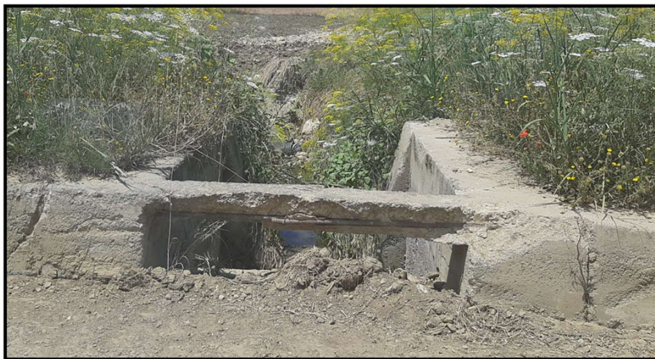
Figura 62 - foto dell'impluvio costituente l'interferenza "Int.69"
