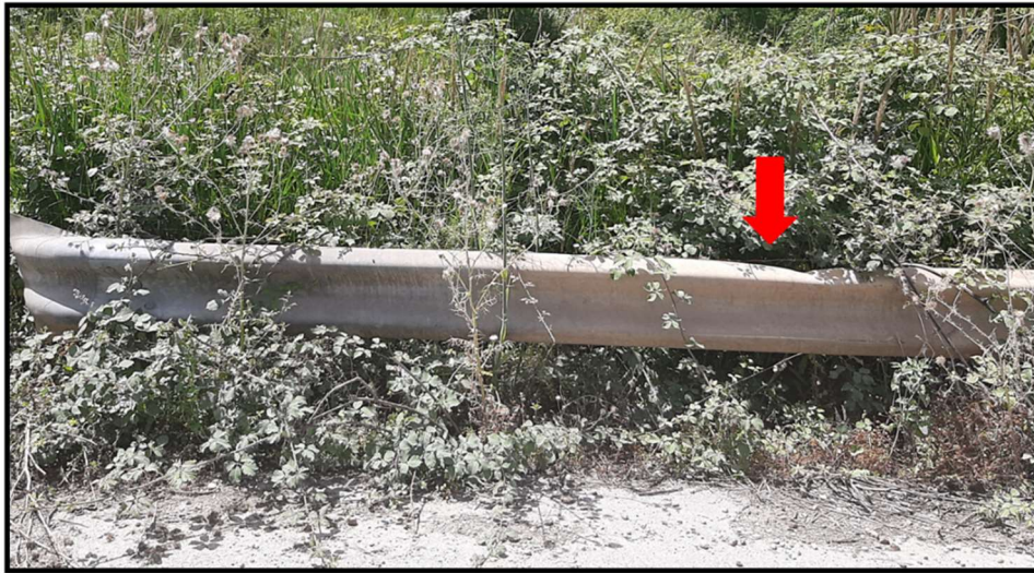
Figura 33 - foto dell'impluvio costituente l'interferenza "Int.37"
