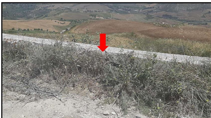
Figura 35 - foto dell'impluvio costituente l'interferenza "Int.40"
