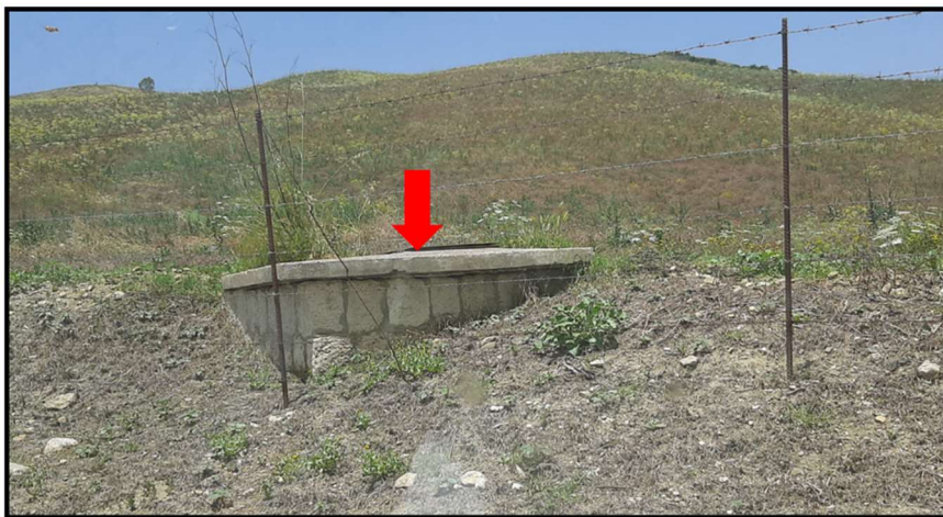
Figura 124 - foto dell'impiuvio costituente l'interferenza "Int.96"
