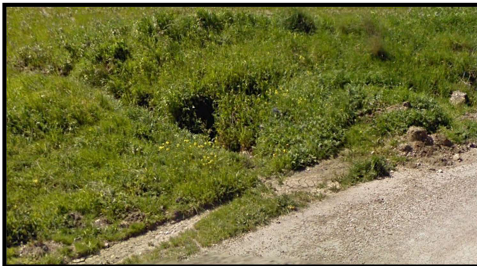
Figura 98 - foto dell'impluvio costituente l'interferenza "Int.114"
