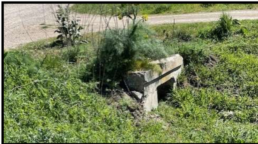
Figura 92 - foto dell'impluvio costituente l'interferenza "Int.108"
