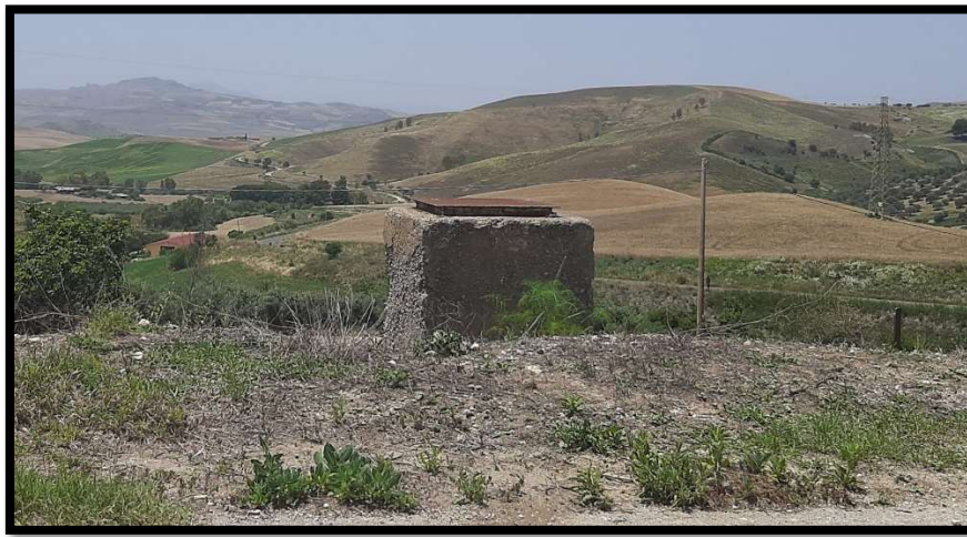
Figura 125 - foto dell'impluvio costituente l'interferenza "Int.97"
