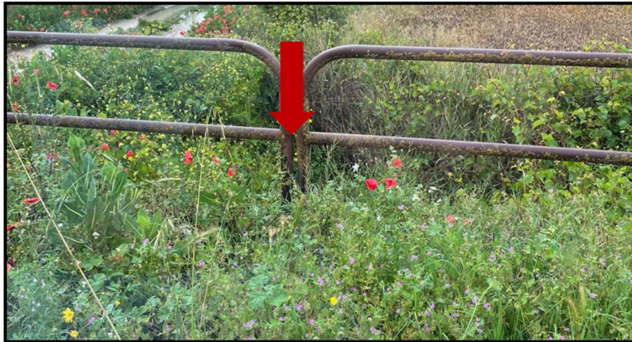
Figura 83 - foto dell'impluvio costituente l'interferenza "Int.94"
