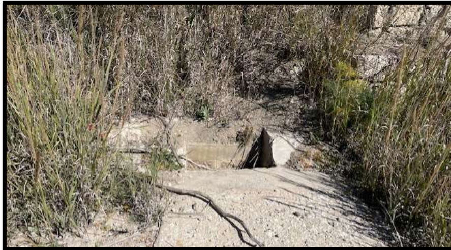
Figura 91 - foto dell'impluvio costituente l'interferenza "Int.107"
