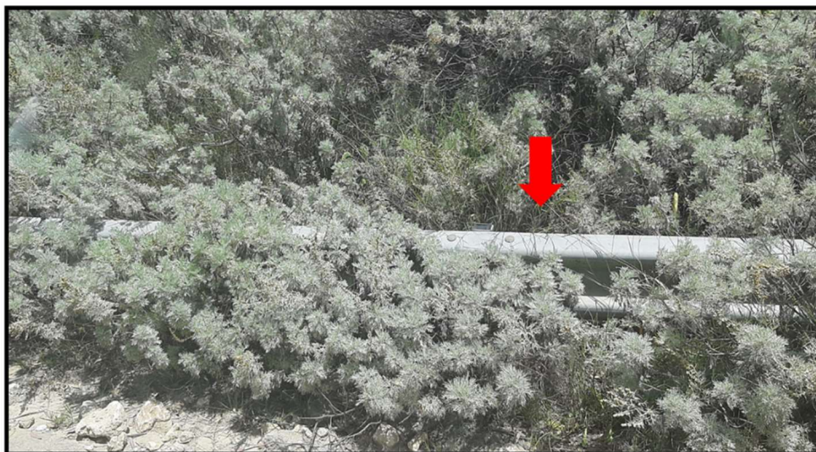
Figura 50 - foto dell'impianto costituente l'interferenza "Int.56"
