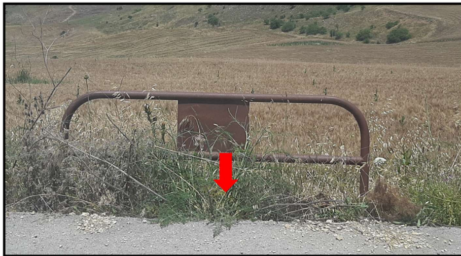
Figura 39 - foto dell'impluvio costituente l'interferenza "Int.45"
