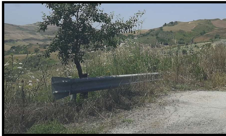
Figura 101 - foto dell'impluvio costituente l'interferenza "Int.29"
