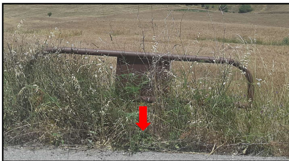
Figura 40 - foto dell'impluvio costituente l'interferenza "Int.46"
