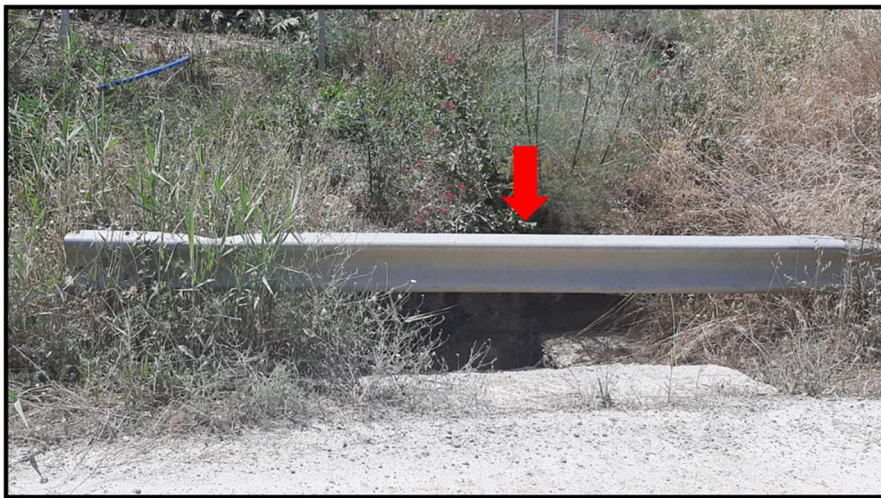
Figura 31 - foto dell'impluvio costituente l'interferenza "Int.35"
