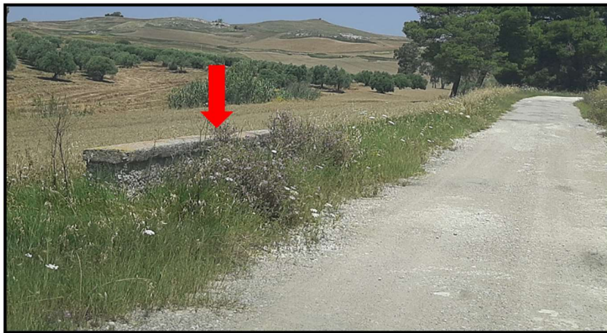
Figura 19 - foto dell'impluvio costituente l'interferenza "Int.19"
