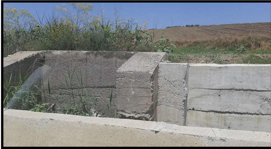
Figura 61 - foto dell'impluvio costituente l'interferenza "Int.68"
