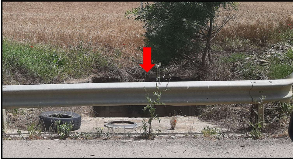
Figura 67 - foto dell'impluvio costituente l'interferenza "Int.77"
