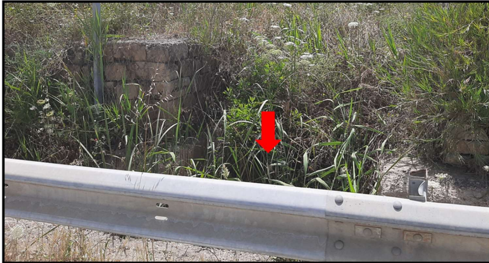
Figura 75 - foto dell'impluvio costituente l'interferenza "Int.86"
