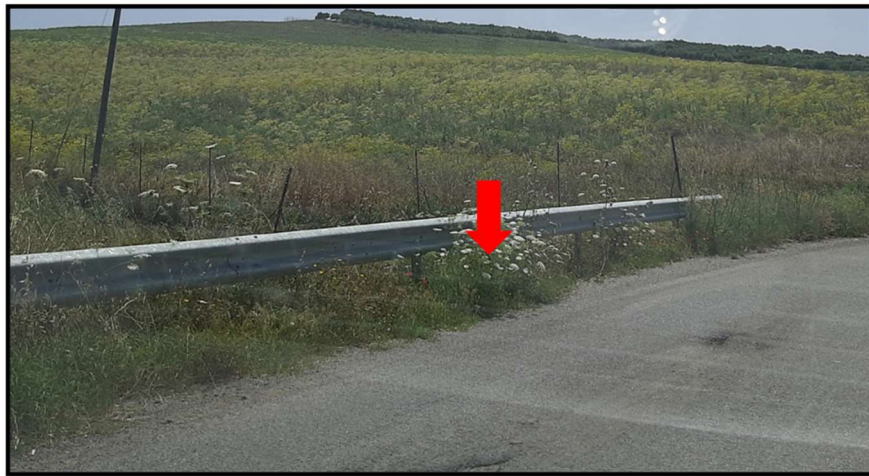
Figura 109 - foto dell'impluvio costituente l'interferenza "Int.73"
