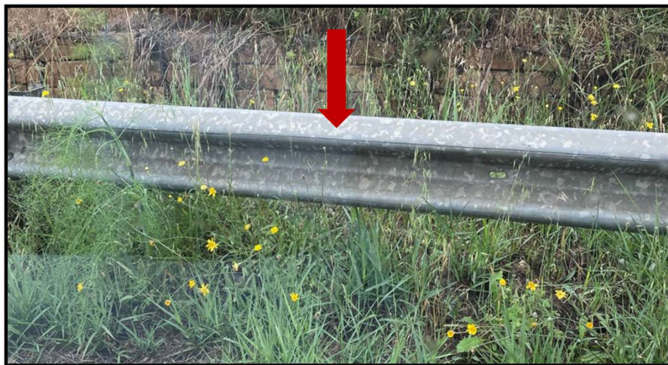
Figura 80 - foto dell'impluvio costituente l'interferenza "Int.91"
