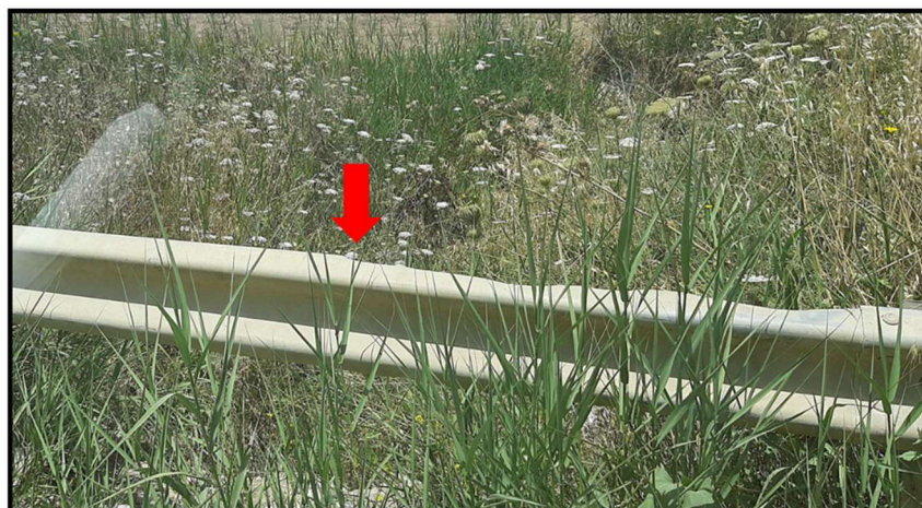
Figura 106 - foto dell'impluvio costituente l'interferenza "Int.66"
