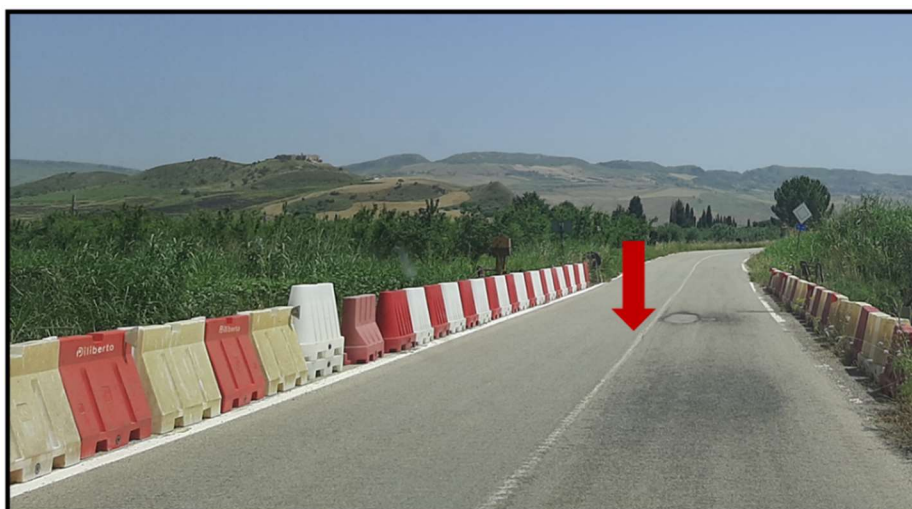
Figura 16 - foto dell'impluvio costituente l'interferenza "Int.16"
