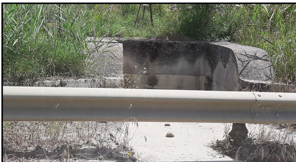
Figura 66 - foto dell'impluvio costituente l'interferenza "Int. 76"
