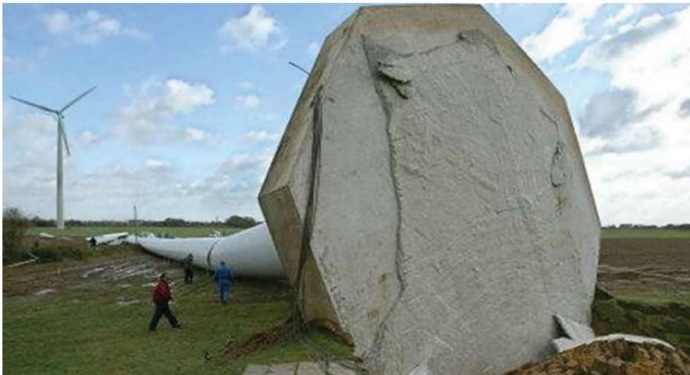
*Figura 9- Ribaltamento della torre e del plinto*
