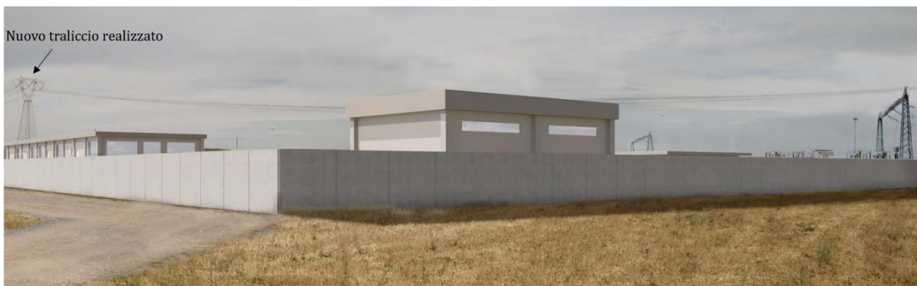
Figura 94: Fotosimulazione 1 Stazione Elettrica (SE) di Trasformazione 380/150/36 kV “Olmedo 380” – Vista dalla strada di accesso dalla SP 65
