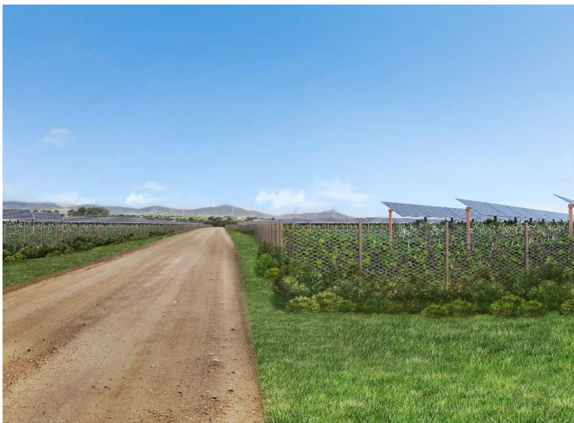
Figura 92: Fotosimulazione 1 impianto agrivoltaico – Vista interna all'azienda agricola Fattoria solare Casa Scaccia
