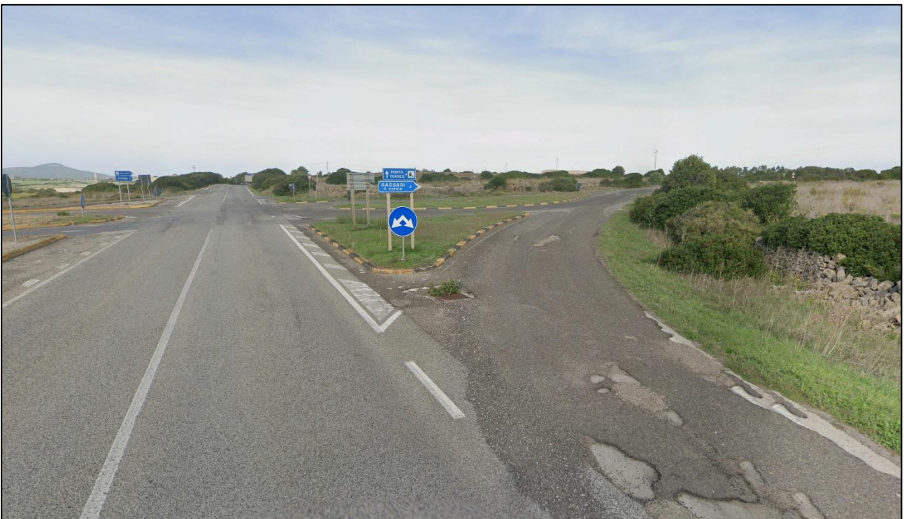
Figura 4: Immagine Incrocio Strada Provinciale SP42 con Strada Provinciale SP65
