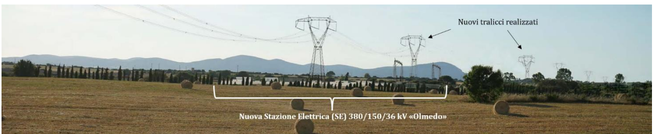
Figura 41: Fotosimulazione 3 Stazione Elettrica (SE) di Trasformazione 380/150/36 kV "Olmedo 380" – Vista da sud-est nei pressi della piazzola di sosta su SS 291
