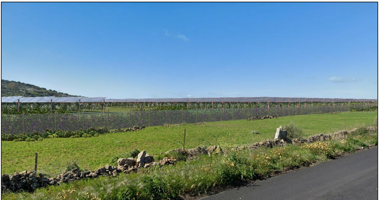
Figura 27: Cono di ripresa n.2 vista da SP65 – Verso Sud intra operam
