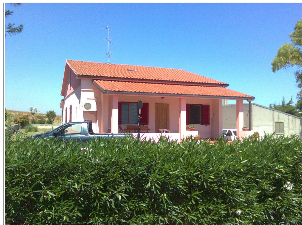
Figura 7-1: Foto dell'edificio 1 potenzialmente interessato dall'intervento in progetto
