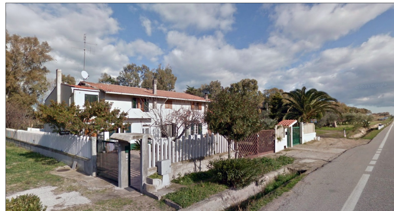
Figura 7-2: Foto dell'edificio 2 non interessato dall'intervento in progetto, ma rappresentativo per la sua posizione dei potenziali effetti di rumore sul SIC
