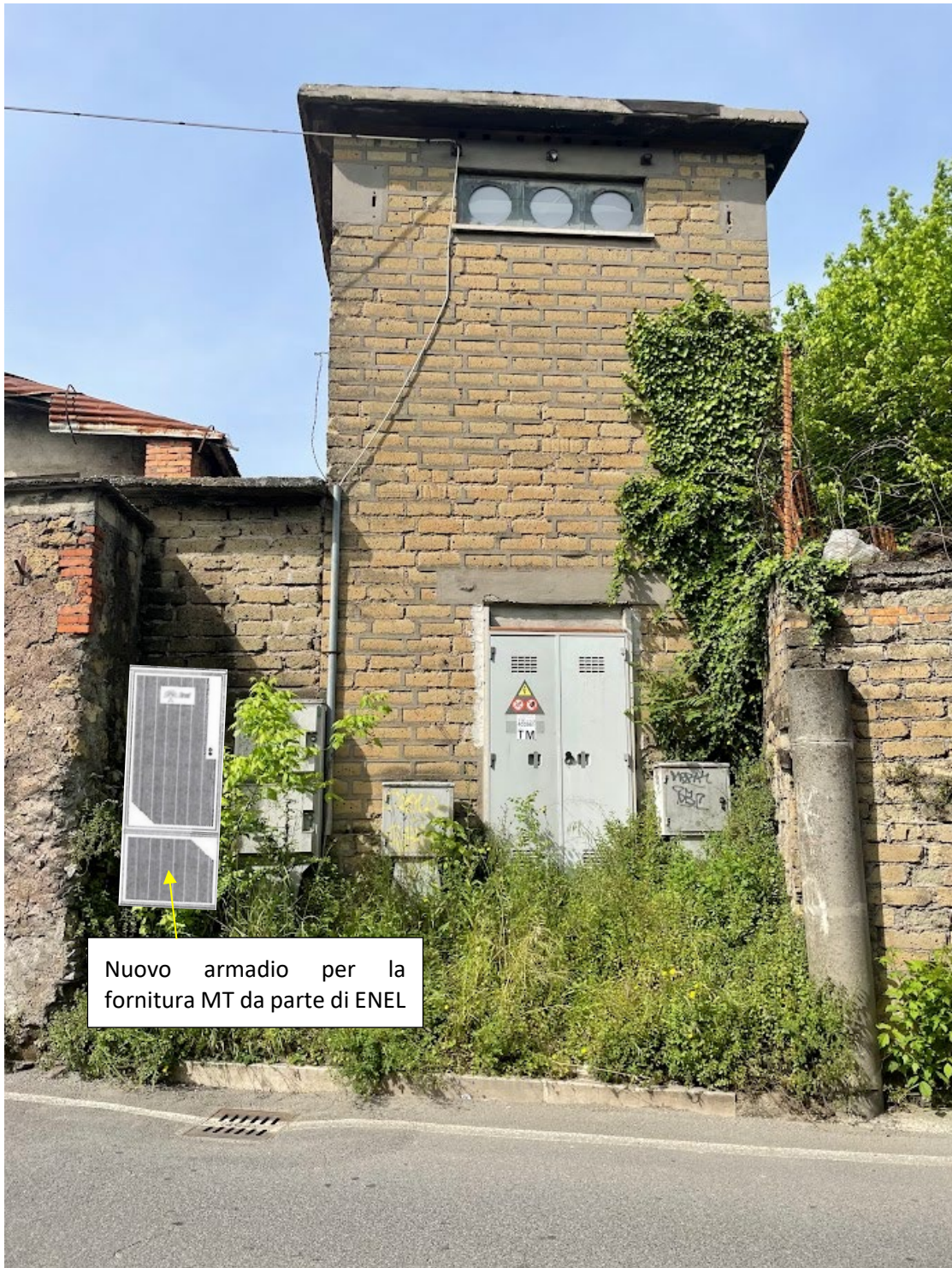
Foto 5.4 – Cabina ENEL presente su via Acquaregna. L'armadietto di consegna su indicazione di ENEL verrà realizzato sul muro di proprietà di ENEL a fianco della cabina.
