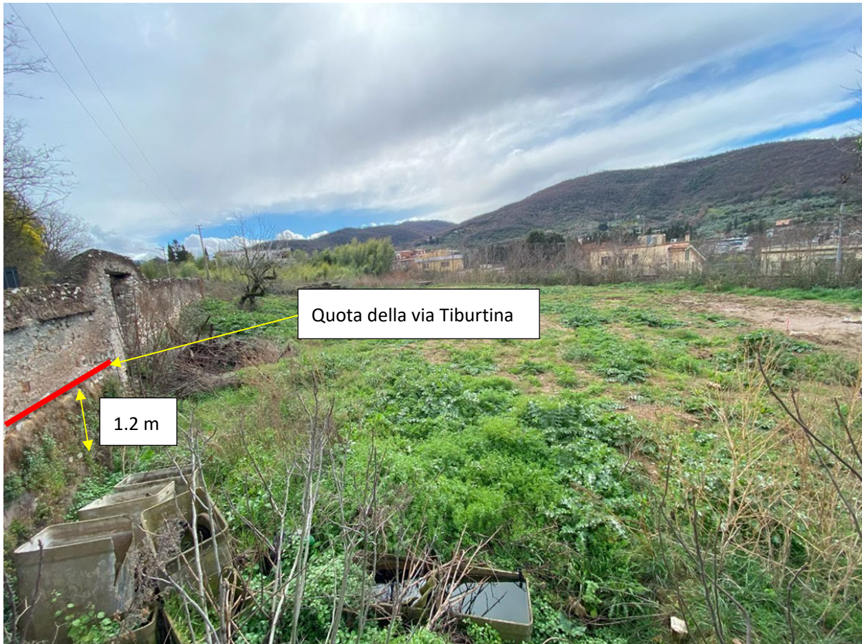
Foto 2.2 – Muro lungo la via Tiburtina. Vista dall’area del cantiere PZ2. Si osserva che la quota della strada è circa 1.2 m più alta del terreno
