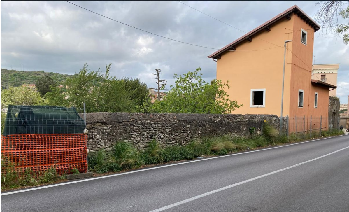
Figura 4.1 – Muro esistente sulla via Tiburtina (in primo piano)
