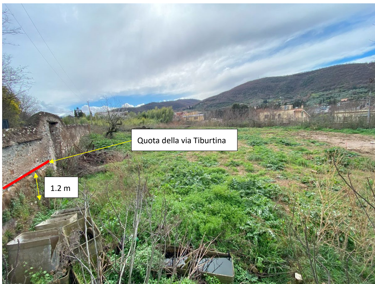
Foto 4.2 – Muro lungo la via Tiburtina. Vista dall’area del cantiere PZ2. Si osserva che la quota della strada è circa 1.2 m più alta del terreno
