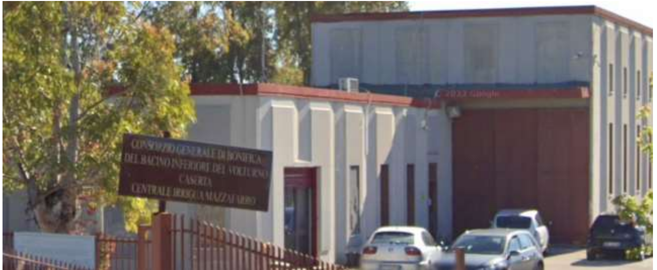
Fig. 2 - Centrale irrigua denominata "Mazzafarro" è gestita dal Consorzio Generale di Bonifica del Bacino Inferiore del Volturno Caserta.
