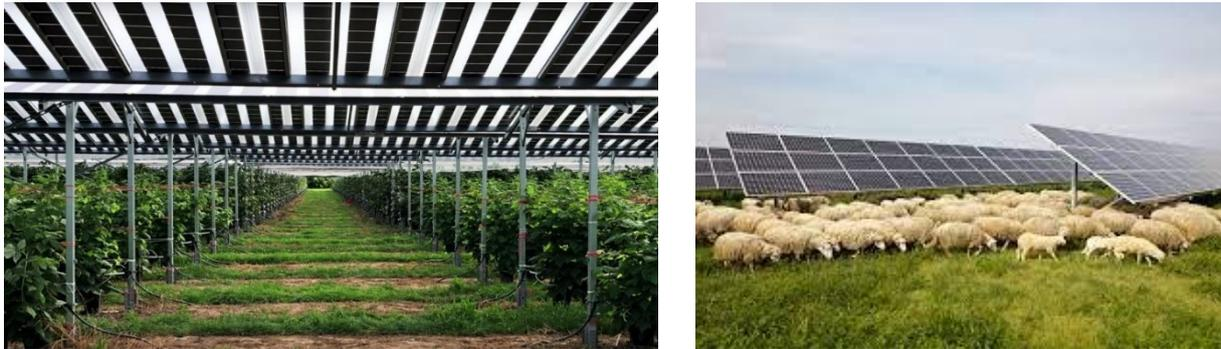
Figura 16: esempio di agrovoltaico (fotovoltaico con sottostante coltivazione, a sinistra, o pascolo, a destra)
