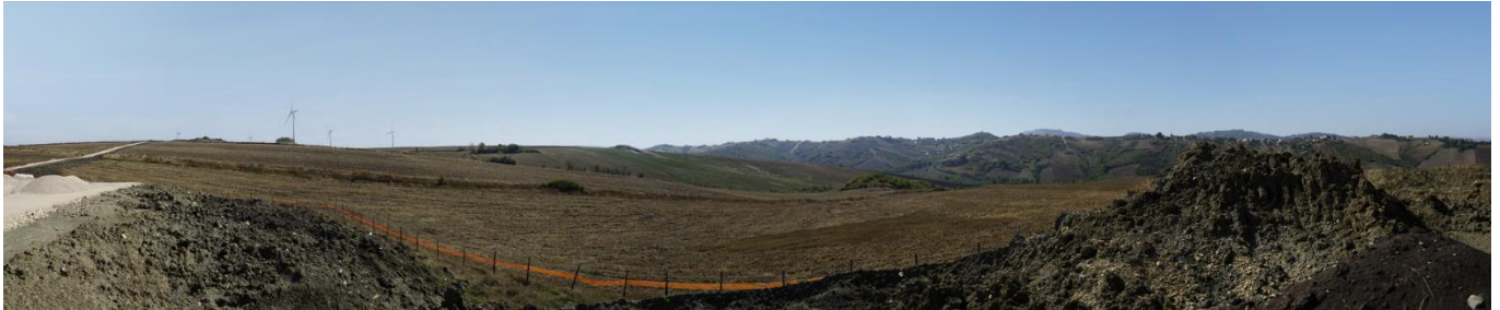
Figura 48: Stato dei luoghi ex-ante in corrispondenza del punto di ripresa fotografica PR_3
