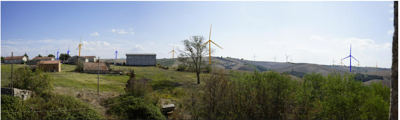
Figura 67: Stato dei luoghi ex-post in corrispondenza del punto di ripresa fotografica PR_12
