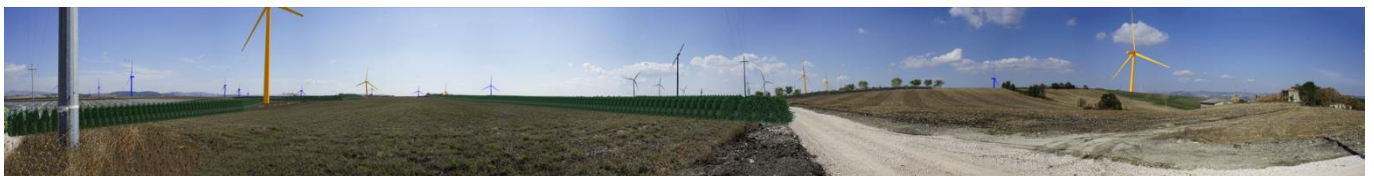
Figura 55: Stato dei luoghi ex-post in corrispondenza del punto di ripresa fotografica PR_6
