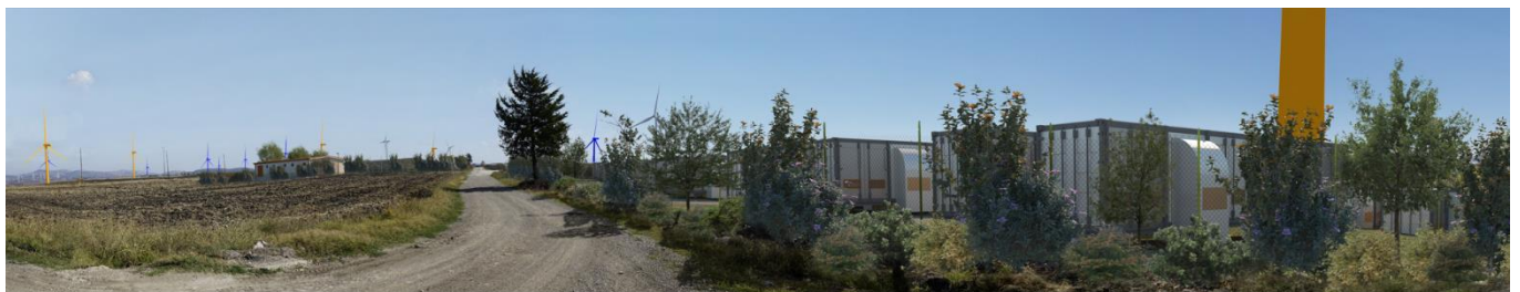
Figura 51: Stato dei luoghi ex-post in corrispondenza del punto di ripresa fotografica PR_4
