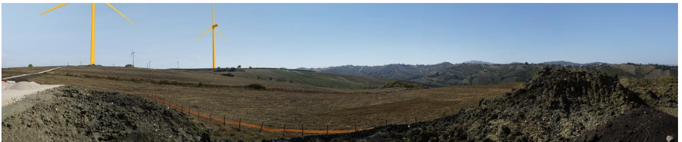
Figura 49: Stato dei luoghi ex-post in corrispondenza del punto di ripresa fotografica PR_3
