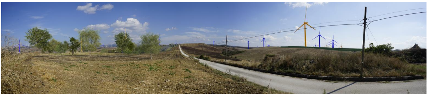
Figura 65: Stato dei luoghi ex-post in corrispondenza del punto di ripresa fotografica PR_11
