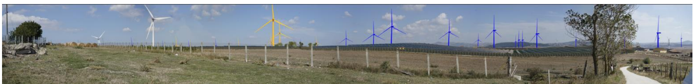
Figura 57: Stato dei luoghi ex-post in corrispondenza del punto di ripresa fotografica PR_7
