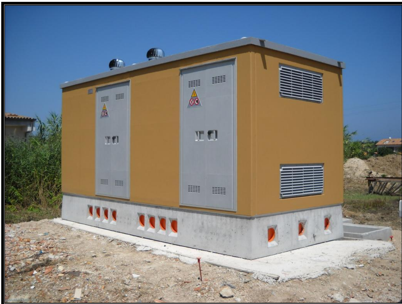
Figura 9 - Esempio di cabina di parallelo AT
