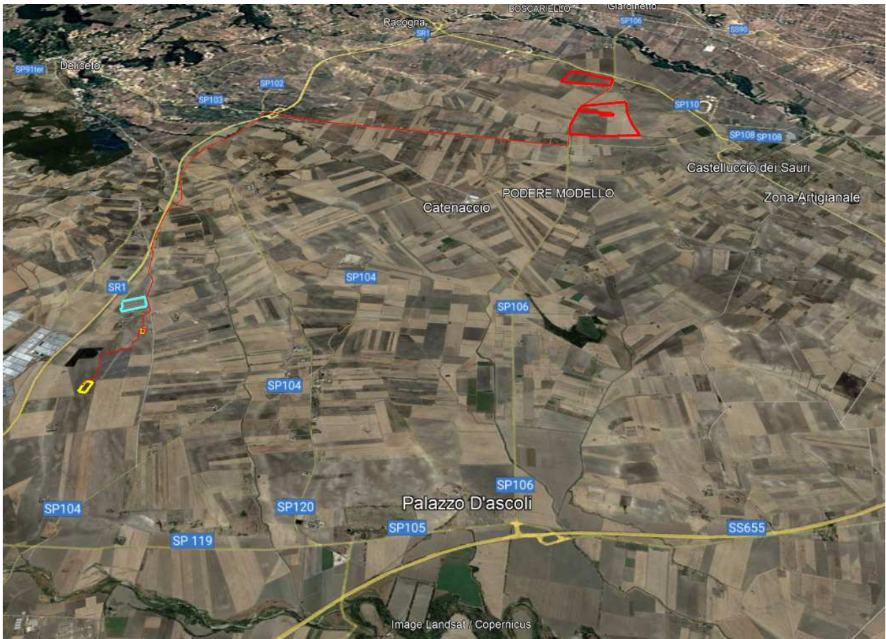
L'area occupata dalle strutture in progetto con visuale da est verso ovest, in area vasta
