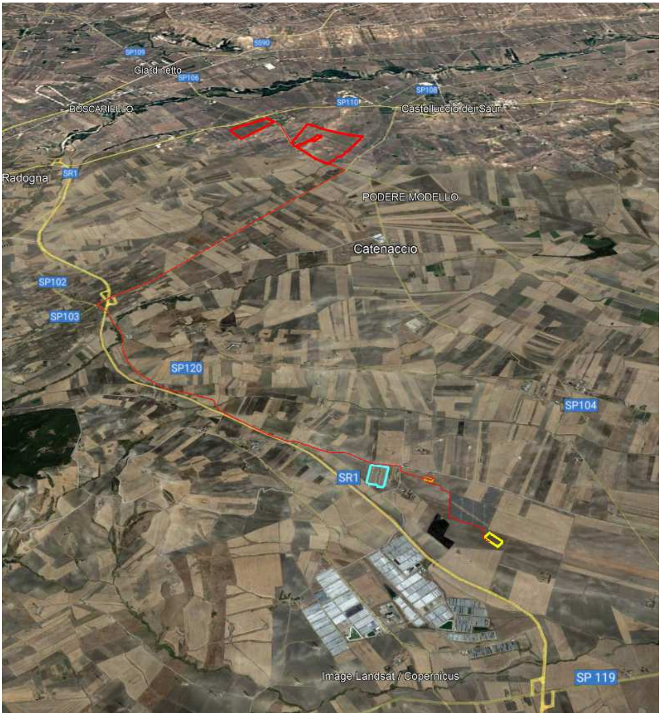
L'area occupata dalle strutture in progetto con visuale da sud verso nord, in area vasta
