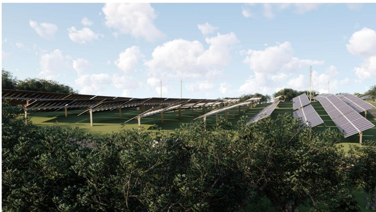
Figura 13 – Esempio di fascia di mitigazione dell'impianto
